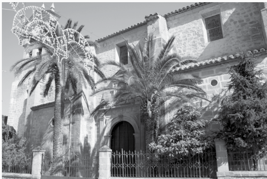
Figura 1. Fachada principal de la Iglesia de San Pablo en Baeza, sede actual de la Archicofradía de Nuestro Padre Jesús Nazareno y la Cruz de Santa Elena, “El Paso” (Foto del autor).
