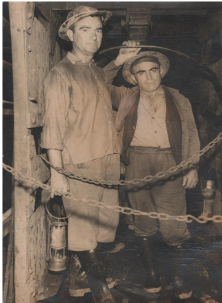
“Jaula”, ascensor al interior de las minas. 30 de Septiembre de 1967.
