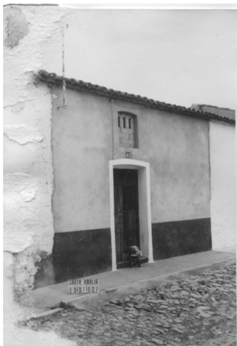
Fot. 1. Medias casas: Con un pasillo con una o dos habitaciones a un solo lado del mismo, sin otra ventilación que la puerta de la calle y la del corral.
