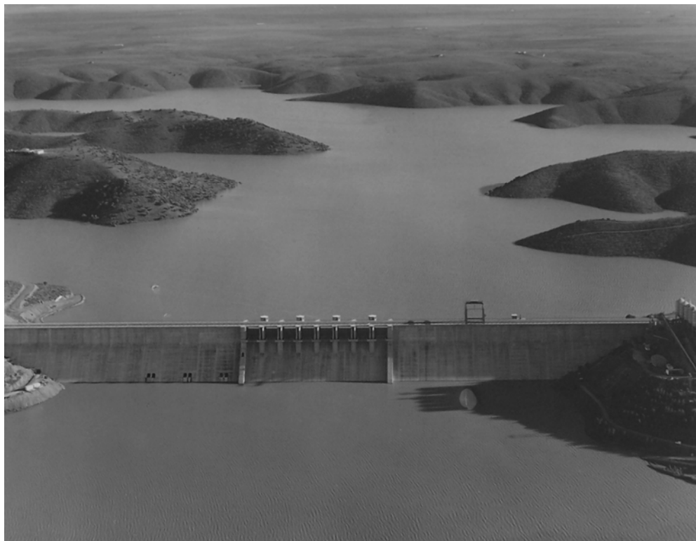
Vista aérea de la Presa de la Serena desde aguas abajo
