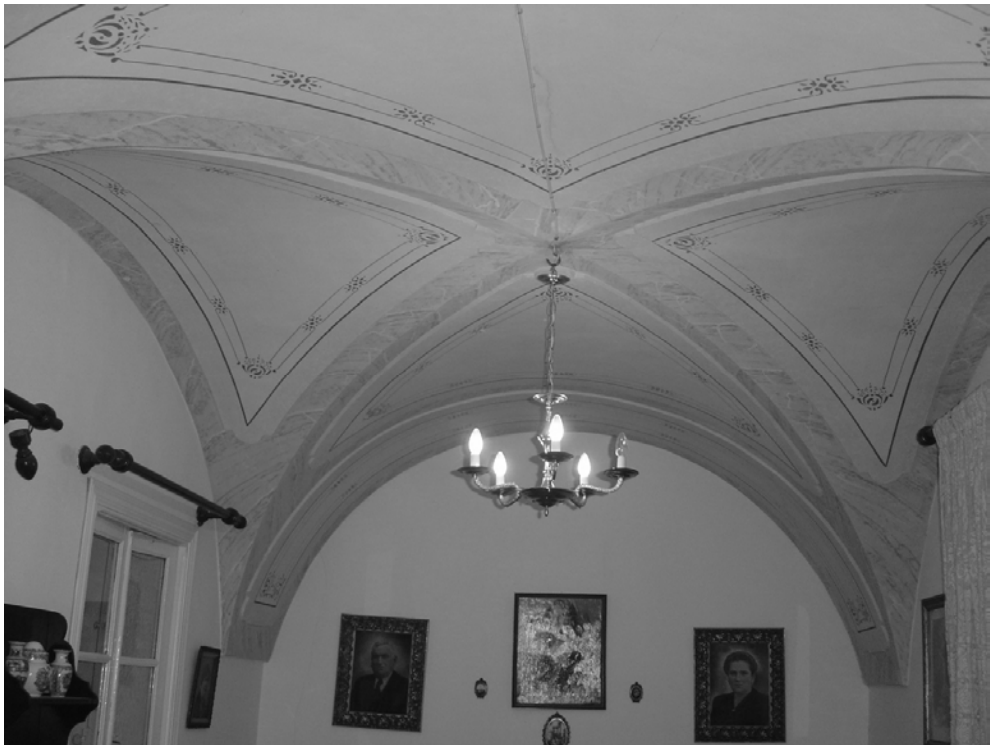
Fot. 13. Bóveda en aristas.
