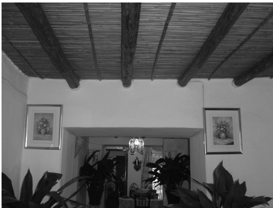
Fot. 12. Techo de cañizo.
