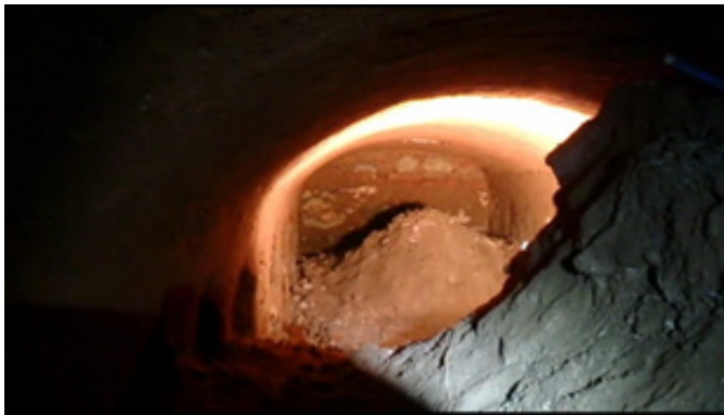
Fig. 11: Tierra que se acumula en el interior de la cripta. Fotografía: Manuel Toro Rosa.
