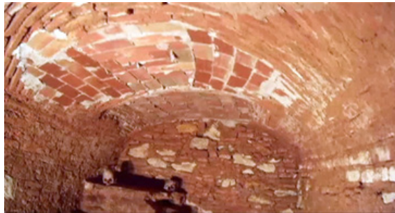
Fig. 3: En la bóveda se aprecia el hueco que abrieron en el verano de 1979 para acceder al corazón de la cripta.
