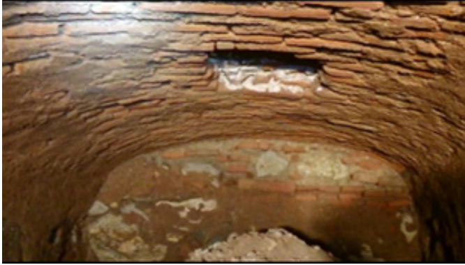
Fig. 10: Detalle de uno de los registros abiertos en el techo de la cripta por el que vertían la tierra procedente de las obras. Fotografía: Manuel Toro Rosa.
