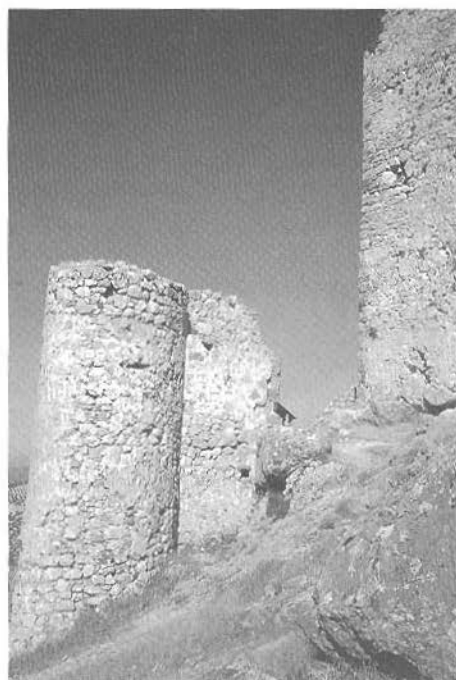
Fig. 14: Detalle del amurallamiento de la villa del castillo del Hierro. Foto M. Valor. 2001
