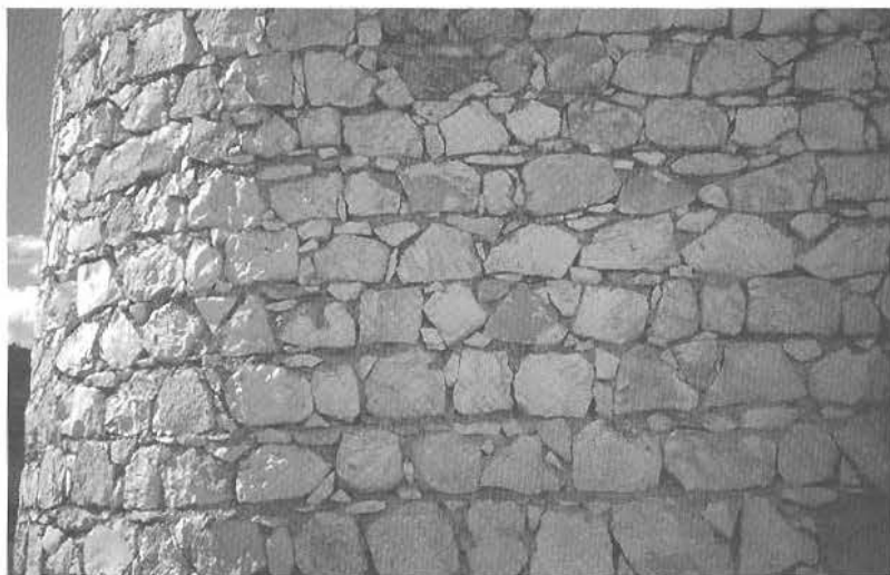
Fig. 3: Aparejo de la muralla de la villa. Foto M. Valor. 1998
