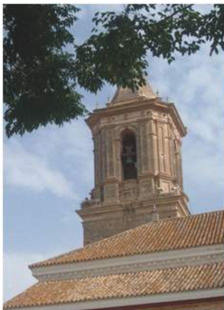
Figura 5. Detalle del campanario de la torre.
