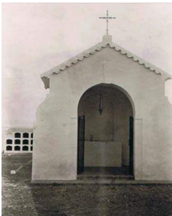
Exterior e interior del cementerio
