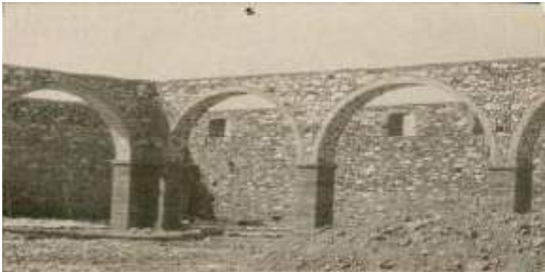
Obras del mercado de abastos. Interior
