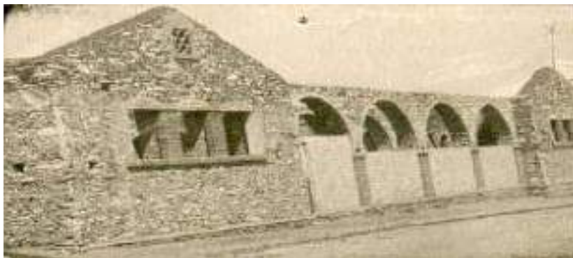
Obras del mercado de abastos. Exterior
