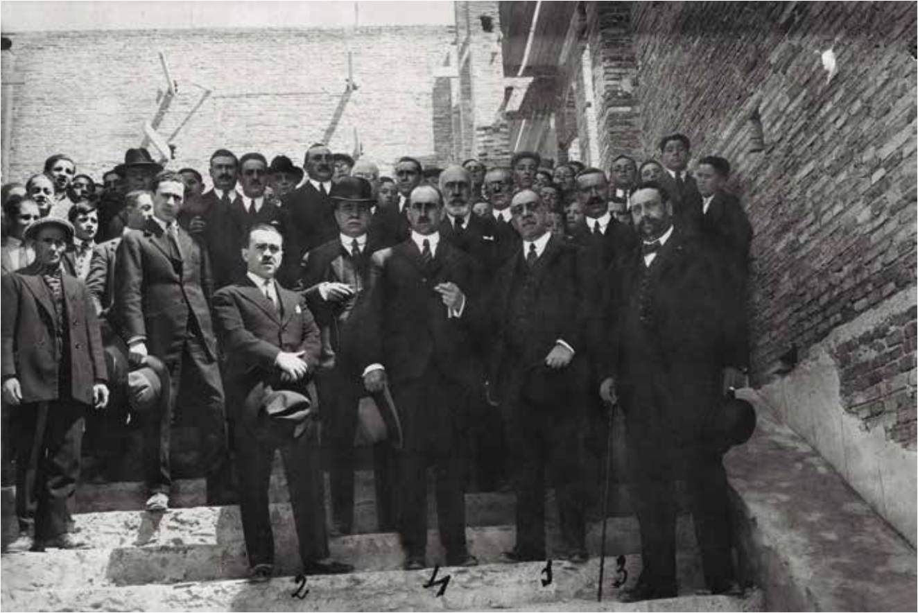
Fig. 2. Visita del Subsecretario de Instrucción Pública a las obras en construcción del Instituto. (1. Javier García de Leaniz, subsecretario de Instrucción Pública; 2. Julio Carrilero Prat, arquitecto municipal y coautor del proyecto; 3. José Salas y Vaca, gobernador civil de la provincia de Albacete; 4. Paulino Cuervas-Mons y Díaz de Quijano, alcalde de Albacete; al fondo, profesores y demás autoridades). ©Archivo Familia Carrilero. Fotografía: Luis Escobar López.
