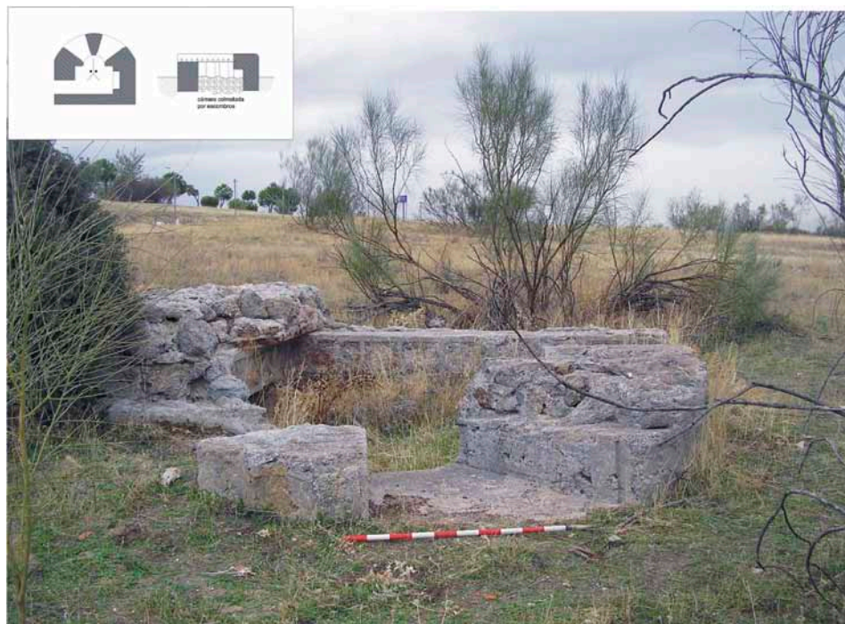
Fig. 2.- Nido del Cerro Mocho que ha perdido su blindaje superior. Se aprecian los rebajes para los cierres en la tronera.
