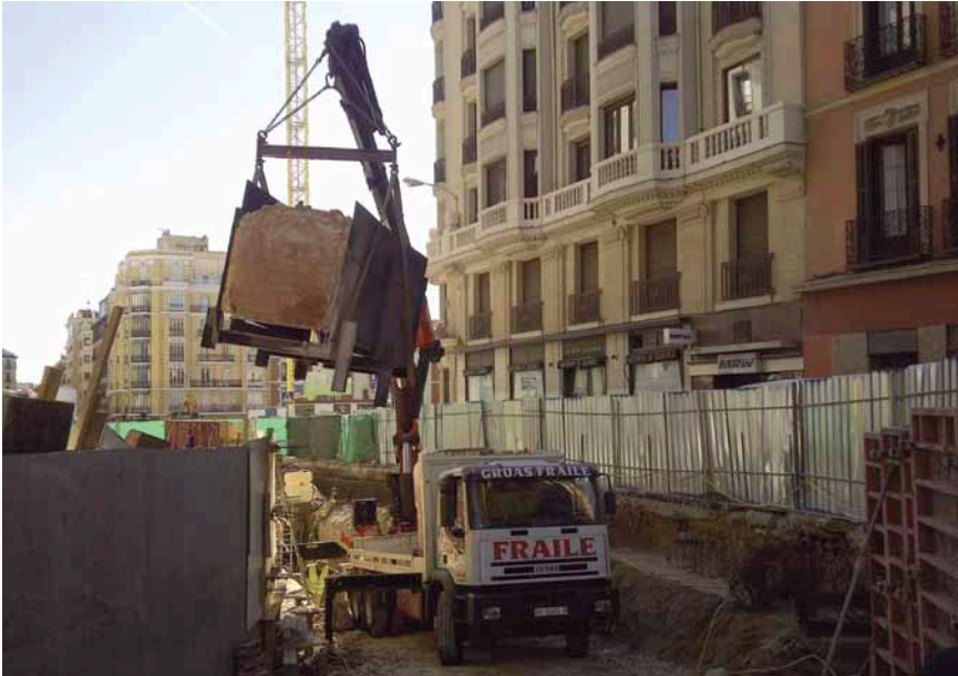
Fig. 5.- Extracción de las piezas cortadas.
