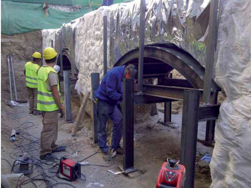
Fig. 3.- Colocación de los camones.
