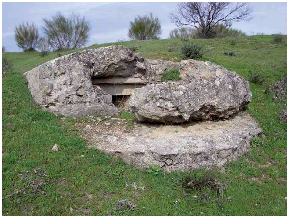
Fig. 3.- El techo partido de esta obra del arroyo de la Puentequilla permite apreciar el negativo de los raíles de ferrocarril.
