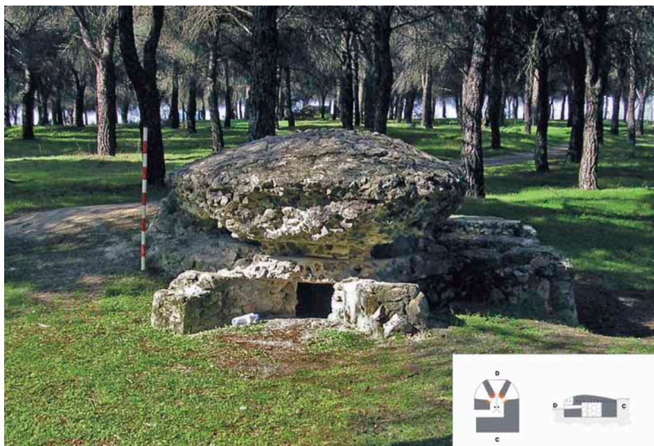
Fig. 1.- El techo curvo de esta casamata de la Dehesa de Navalcarbón ha quedado en forma de seta al picarlo para extraer los raíles, dejando su negativo en el hormigón.
