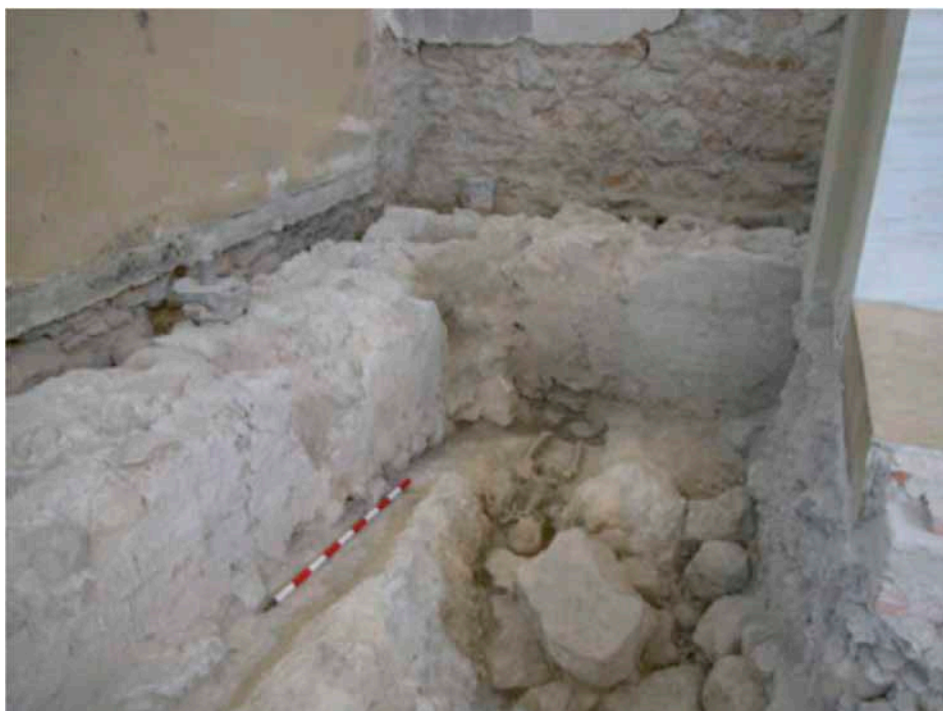
Fig. 2.-Panorámica de los restos de muro/cimentación del siglo XIII con restos de revoco y encofrado (zona de la cabecera).
