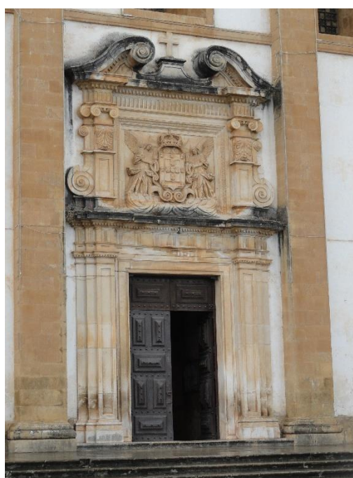
Fig. 2. Portal da igreja de Santa Clara-a-Nova , 2014. Igreja de Santa Clara-a-Nova, Coimbra. Foto: [JPP].
