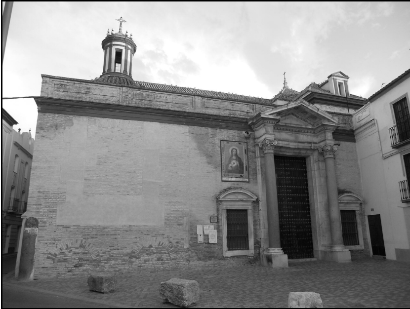
1. Vista de la fachada del evangelio de la iglesia de Santa Bárbara de Écija. (Foto autor).
