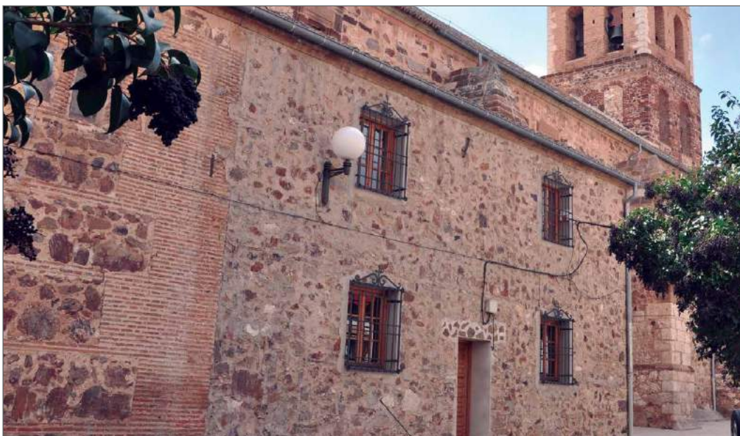
Fig. 51 La construcción de la actual sacristía propició la destrucción de la antigua capilla de San Benito
