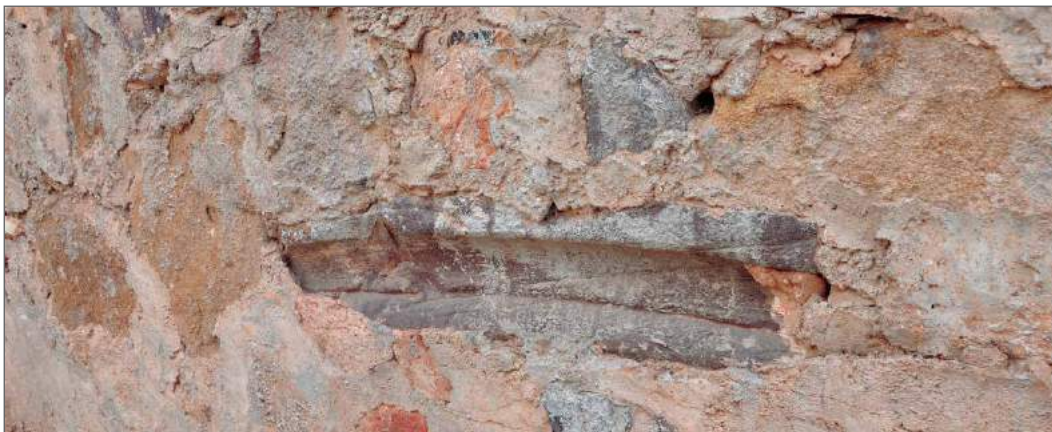
Fig. 60 Restos de la antigua capilla de San Benito reutilizados en la construcción de la actual sacristía
