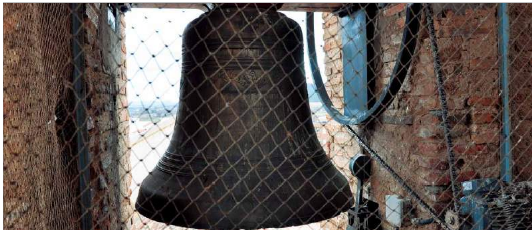
Fig. 58 Una de las nuevas campanas instaladas en 1951
