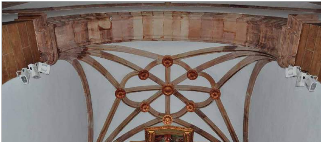
Fig. 18 Bóveda de crucería de la primera capilla del altar mayor construida por Egas
