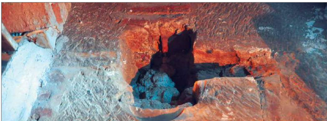
Fig. 26 Todavía se conservan en el primitivo cuerpo de campanas los huecos destinados a sostener el yugo o contrapeso de las campanas
