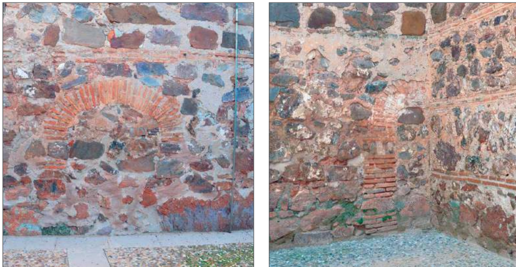
Figs. 28-29 En el lado sur y norte de la capilla mayor todavía hoy se conservan restos de estas puertas o postigos que se abrieron para facilitar el acceso al altar mayor cuando la iglesia estaba en obras
