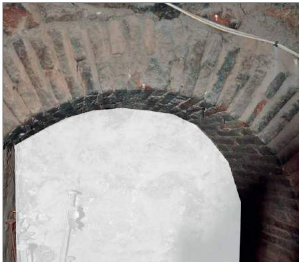
Figs. 44 La nueva entrada abierta en la parte inferior de la torre inutilizó las antiguas puertas de acceso del primer cuerpo (como la que se puede ver en la imagen)
