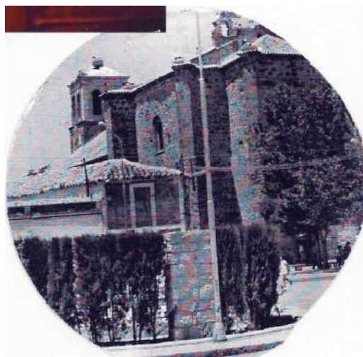
Fig. 5 Imagen de la iglesia en la primera mitad del siglo XX. Véase en el tejado la espadaña, hoy desaparecida. Fotografía cedida por Luis Rubio
