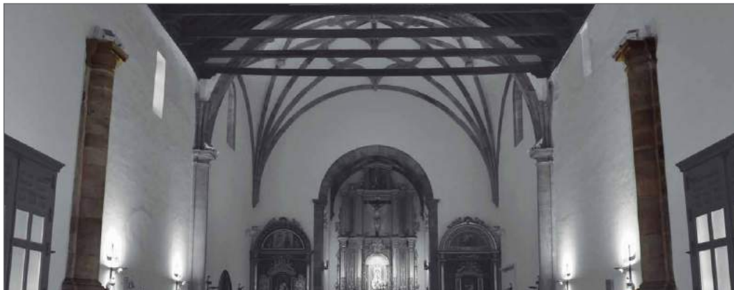
Figs. 35 Las semicolumnas toscanas nunca llegaron a sostener las bóvedas que estaban proyectadas
