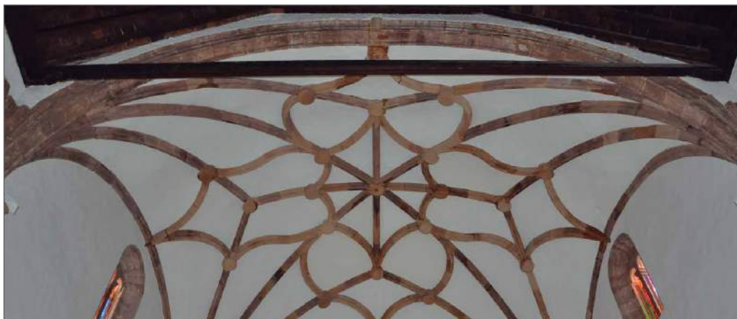
Fig. 19 Bóveda de crucería de la segunda capilla del altar mayor construida por Egas
