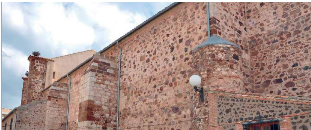
Fig. 49 A la derecha de la imagen se aprecia el contrafuerte semicircular levantado en 1760
