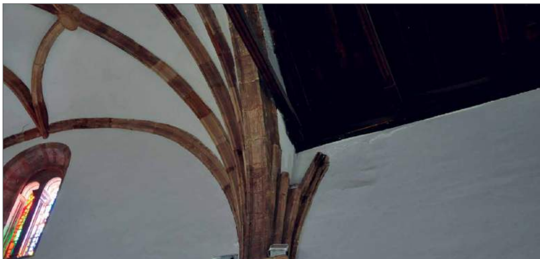
Fig. 22 Nervios incompletos sobre el arco toral
