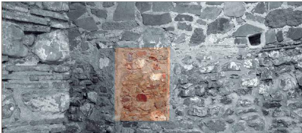
Figs. 42 Antigua ventana, hoy tapiada, que iluminaba la sacristía que se localizaba bajo la capilla mayor
