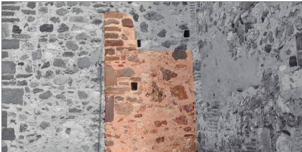
Fig. 11 En la parte exterior podemos apreciar como la torre se levantó sobre una construcción anterior
