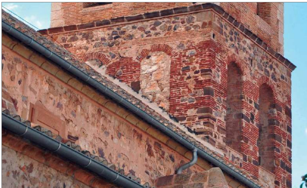
Fig. 24 Cerramiento del antiguo cuerpo de campanas visto desde el exterior de la torre
