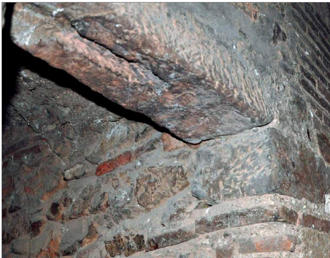
Fig. 9 Para la construcción de la torre parece que se reutilizaron varios sillares procedentes de alguna construcción anterior de origen medieval o antiguo
