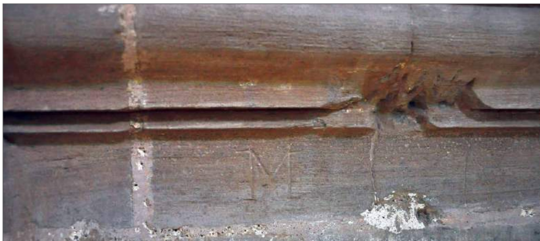
Figs. 36 Detalle. Marca de cantero en forma de M conservado en uno de los plintos que sostienen las columnas toscanas
