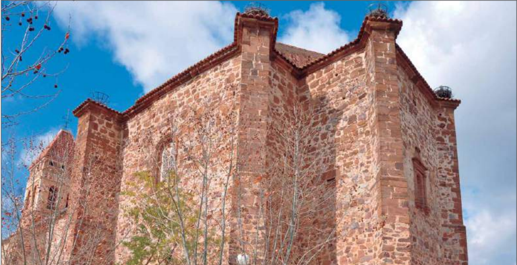
Fig. 21 La monumental capilla mayor de la iglesia fue construida por Enrique Egas el Mozo
