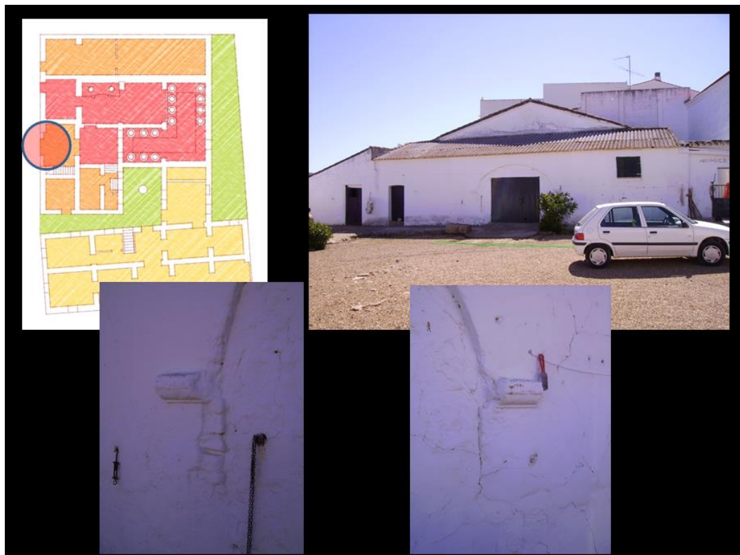
Fig. 7.- Arco de fachada principal de la antigua casa de la Encomienda.
