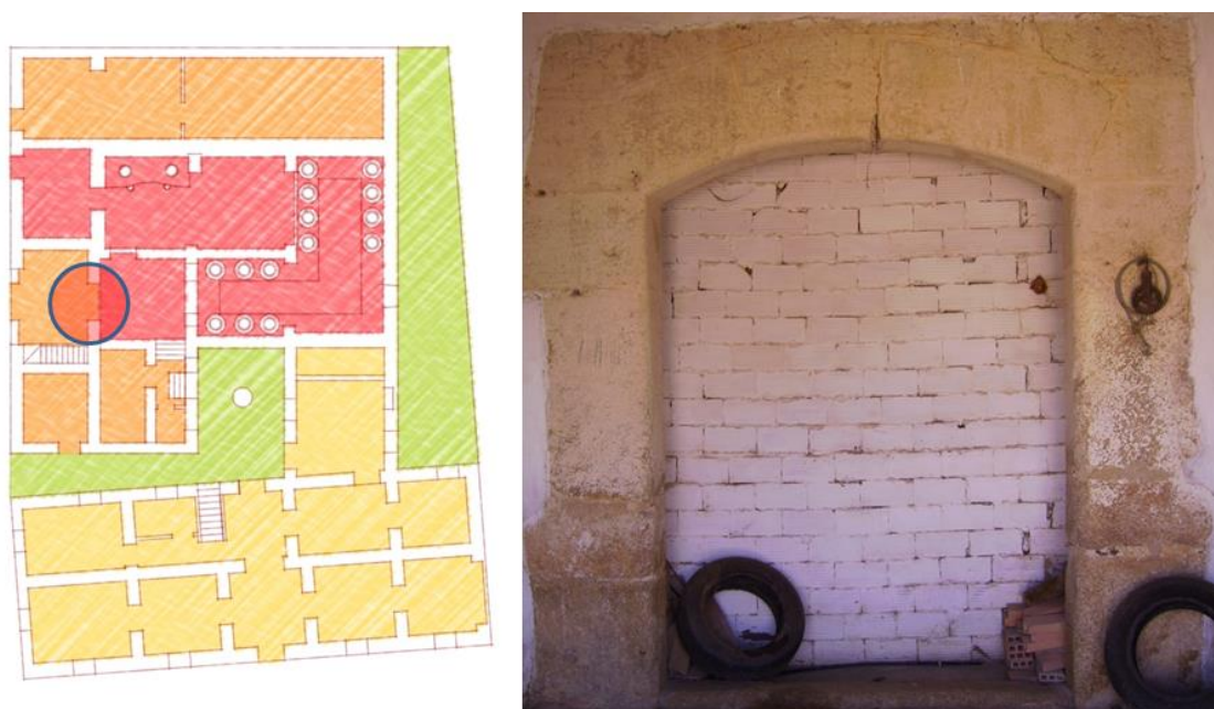
Fig. 8.- Arco escarzano de acceso a las dependencias de la antigua casa de la Encomienda.
