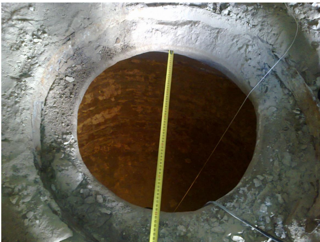
Boca del silo n° 1
