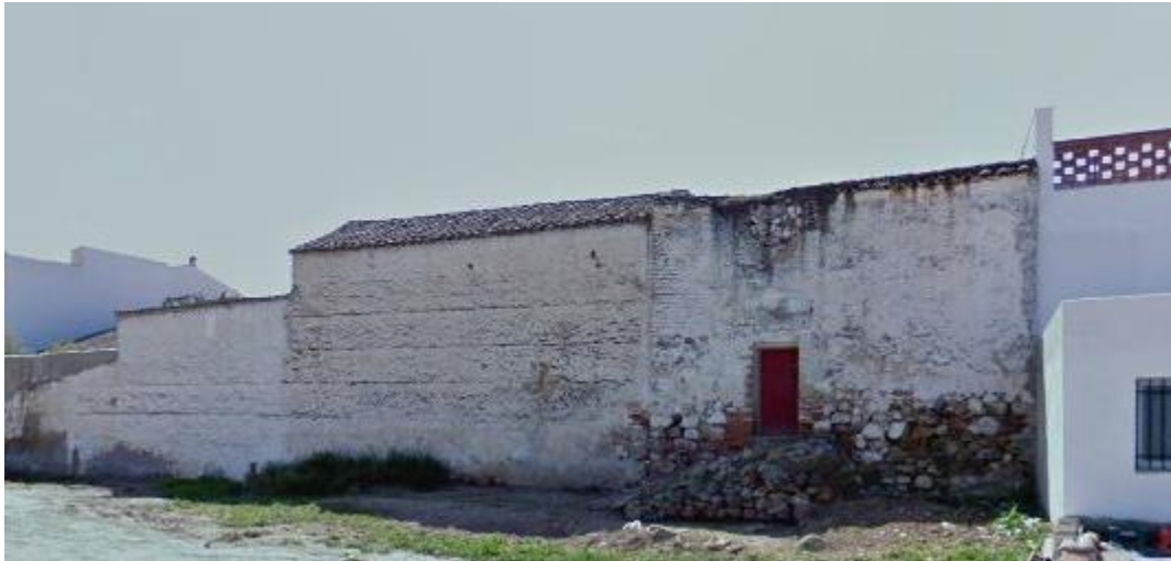
Fig. 5.- Fachada trasera de la casa de la Encomienda (tapia) y vivienda colindante (piedra y ladrillos)
