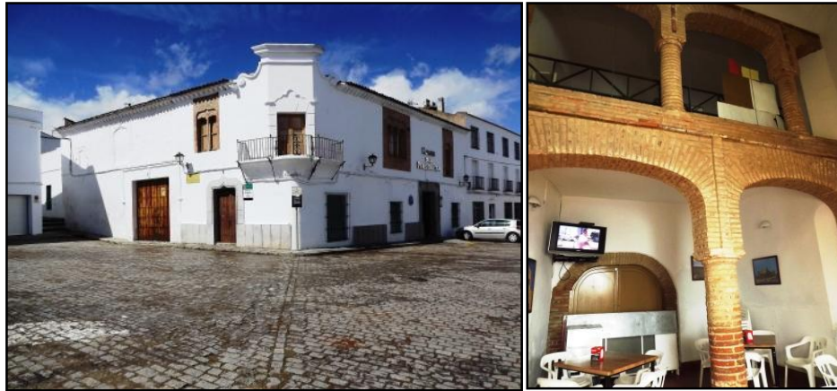
Ilustraciones 4 y 5: Casa Palacio del Gran Maestro (Fuente del Maestro)
