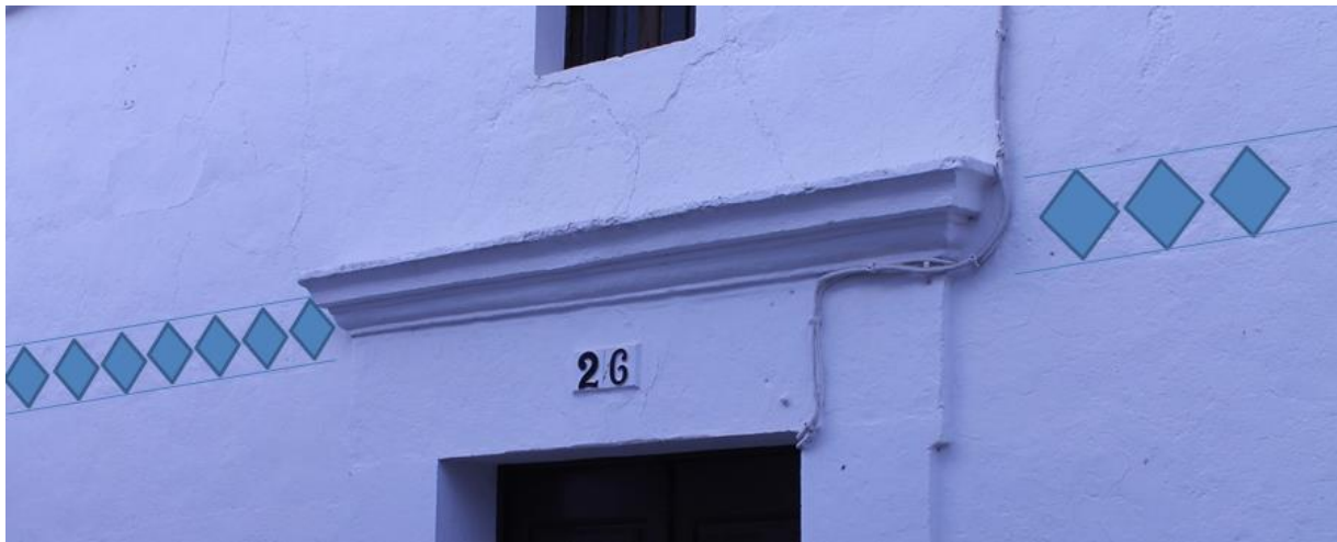
Fig. 14.- Recreación del esgrafiado de la fachada principal.
