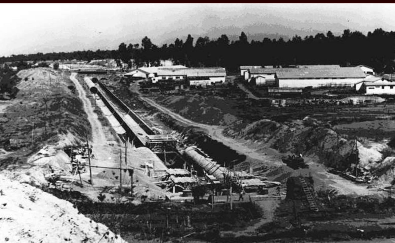
Campo de concentración de la 1ª Agrupación del SCPM en Los Merinales (Sevilla). En primer término, obras del sifón del Copero. Fuente: CHG/Archivo de imágenes de RMHSA_CGT.A.
