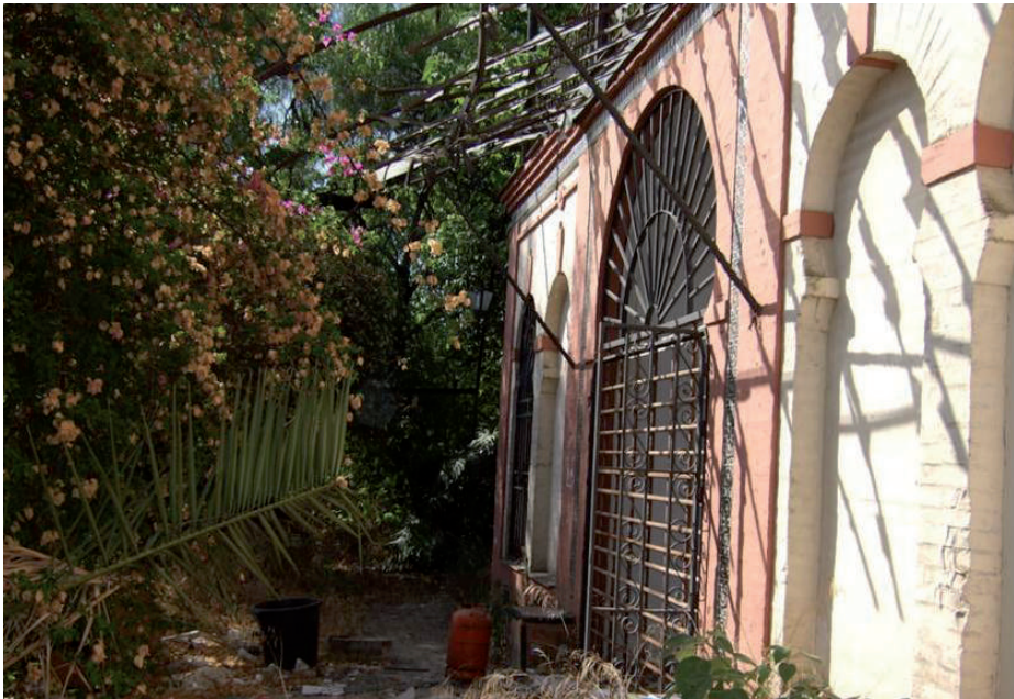
Estado de total abandono en el que se encuentra actualmente Villa Chaboya. Foto: Otto Engelhardt.
