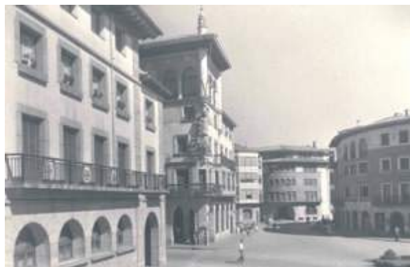
Viviendas en Gernika.
