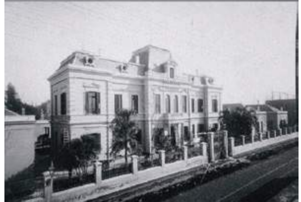
Hospital Francés de Buenos Aires. Plano de distribución. Vista del Pabellón de Administración
