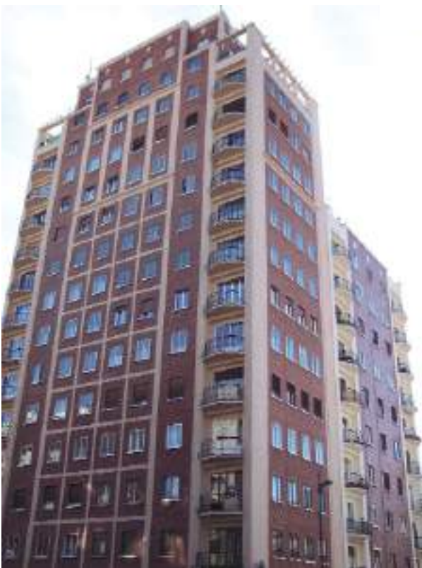
Torre de Salamanca (1958), en la Avenida de Portugal (Salamanca)
