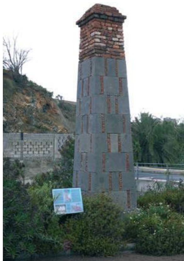
Reproducción actual de la chimenea del ingenio azucarero de Cardones. Parque Granjeros. Arucas. Fotografía: Marcos de Rada
