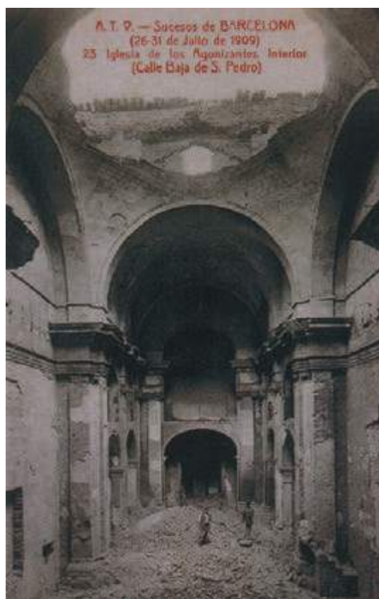
Interior destruido de la Iglesia de los Agonizantes (Barcelona, 1909).
