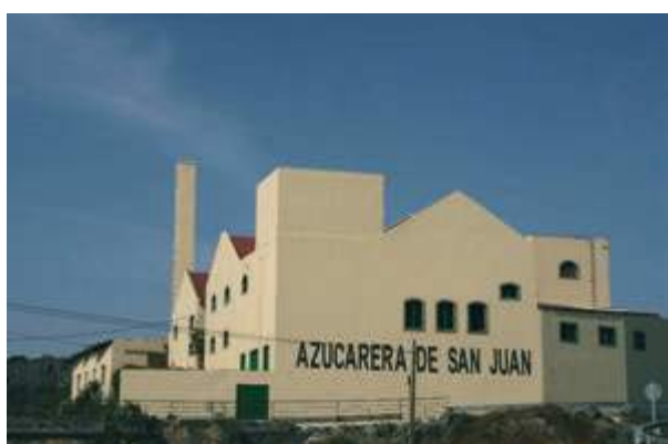
Fábrica Azucarera de San Juan. Telde. Fotografía: Marcos de Rada
