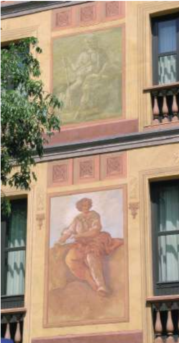
Fachada de la calle Roger de Llúria. En el primer piso, el Dios Apolo y en el segundo la alegoría de la Justicia. (Foto: Alberto López Mullor, 2006)
