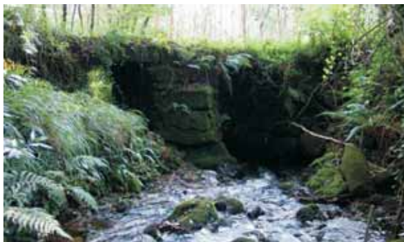
Ponte Lavandeira (Vilamourel, Paderne), Camiño Real Betanzos-Vilalba, cun tallamar sobre o que apoian as lousas da plataforma (arquitecra).
