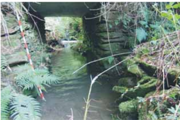
Ponte Barandoi (Monfero), Camiño Real a Viveiro. Ponte con estribos de pedra e plataforma con grandes laxes de pedra.
