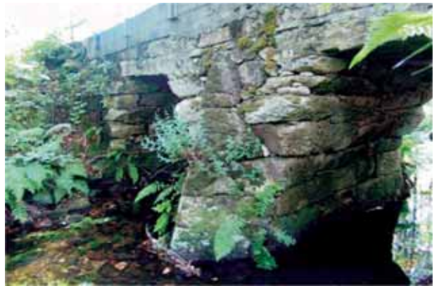
Ponte de Río Seco, Camiño Real a Viveiro. Ponte con estribos, tallamar central con grandes laxes.
