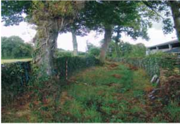
Lugar de Brixeu (Aranga), Camiño Real Aranga-Gallado-Casa Camiño, delimitación do camiño con muros ou «malecóns» cun ancho de calzada 4 m. e presenza significativa de vexetación autóctona.
