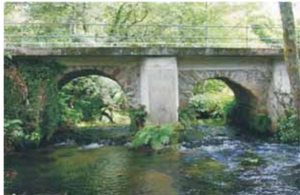
Ponte Nova (Os Chaos, Irixoa), no camiño entre Vila-Mateu e o Chao da Viña. Composta por un tallamar e dous arcos de medio ponto xunto a dous sumidoiros externos.
