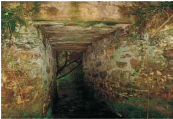
Ponte Barandoi (Monfero), Camiño Real a Viveiro. Ponte con estribos de pedra e plataforma con grandes laxes de pedra.
