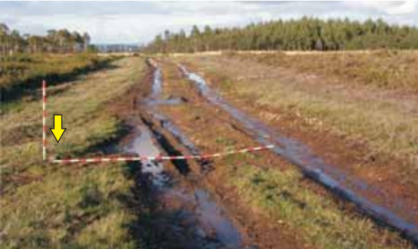
Camiño Bertanzos-Portomarín no Monte da Corda. Na actualidade ten 3 m. úteis, parece que a zona rodada foi o duplo de ancho. Aos lados obsérvase pedras a modo de balizas emprazadas a intervalos regulares
