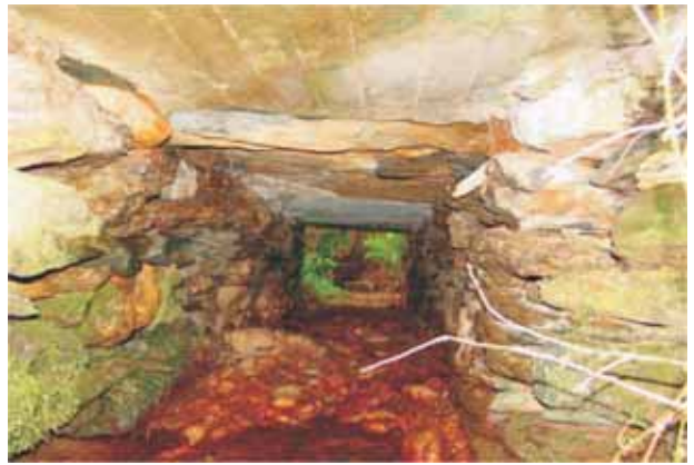
Ponte de Río Seco, Camiño Real a Viveiro. Ponte con estribos, tallamar central con grandes laxes.
