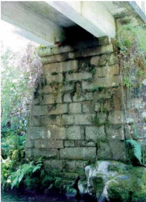
Ponte Xielas (Irixoa), paso polo río Mandeo, facendo de enlace desde a N-VI (Ois, Coirós) a Veríns. Ten un gran piar central (tallamar) para recibir a plataforma arquitrabada desde os estribos laterais. A plataforma orixinalmente debeu ser de madeira, na actualidade é de formigón.
