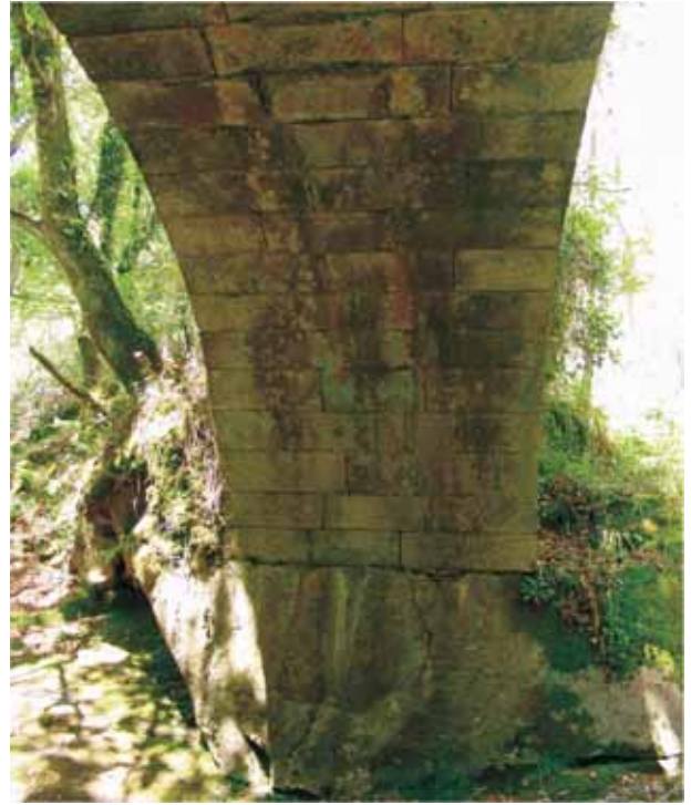
A Ponte Antiga sobre o Lambre, da rede camiños de Chao da Viña (Irixoa) [a Vila-Mateu, Miño]. Detalles da composición da fábrica no interior do bóveda e os apoios sobre a rocha. Detalle do camiño empedrado.
