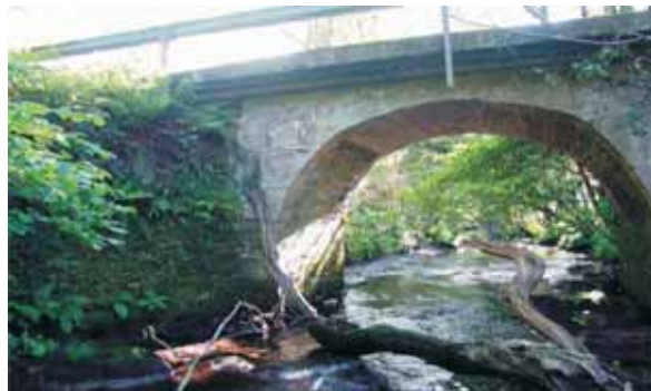
Ponte da Roda Mata (Aranga), sobre o río Cambás, comunica un desvío desde O Carballal con Aranga. A ponte de arco foi alterada substituíndo os arcos e a parte superior da bóveda de pedra por fábrica de formigón.
