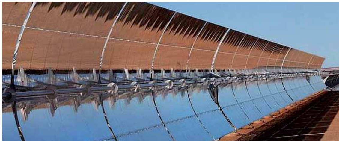
Colector solar cilíndrico en Granada.
