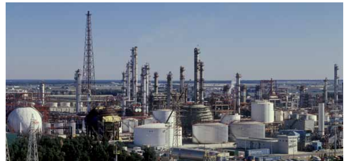
Refinería de CEPSA en San Roque. Cádiz.
