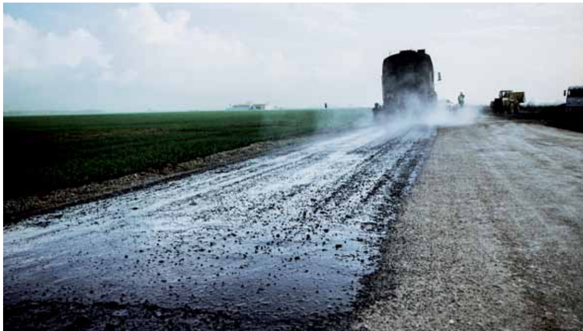
Carretera SE 520 en Alcalá de Guadaíra. Sevilla.
