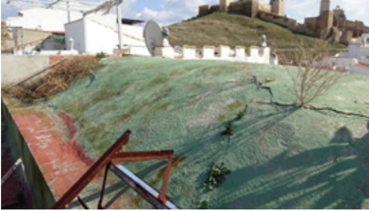
Fig.21. Casa con techo abovedado al principio de la calle Barranco.
