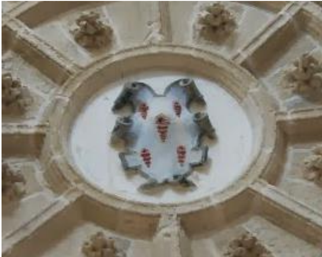
Escudo de la Casa en el crucero oeste del Salón de Pasos Perdidos, en el ala que en principio estuviera dedicada a mujeres, la más antigua del Hospital en su segunda sede al pie de la muralla de La Macarena.
