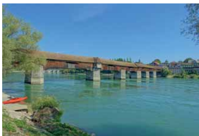
4. PUENTE DE STEIN-SACKINGEN. TOMADO DE HTTPS://TROPTER.COM/ES/SUIZA/STEIN-AARGAU/PUENTE-DE-MADERA-BAD-SACKINGEN
