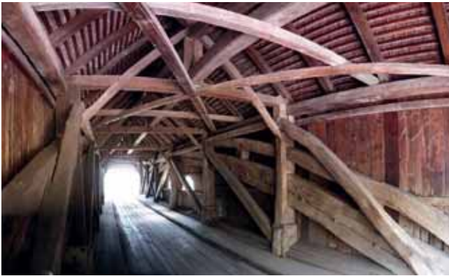
13. PUENTE DE OBERGLATT. (TOMADA DE HTTPS://COMMONS.WIKIMEDIA.ORG/WIKI/FILE:GRUBENMANN_Br%C3%BCcke_Oberglatt_Innen.JPG )
