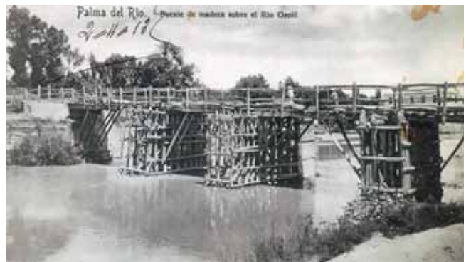
19. PUENTE SOBRE EL GENIL EN PALMA DEL RÍO (CÓRDOBA). TOMADA DE https://saxoferreo.wordpress.com/2018/01/12/proyecto-de-intervencion-de-la-confederacion-hidrografica-del-guadalquivir-sobre-el-rio-genil-a-su-paso-por-palma-del-rio/
