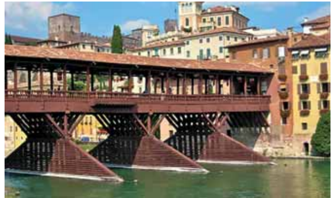
9. PUENTE DE BASSANO DEL GRAPPA DE PALLADIO. (IMAGEN TOMADA DE HTTPS://DONDEVIAJAR.REPUBLICA.COM/CIUDADES/ BASSANO-DEL-GRAPPA-Y-SU-FAMOSO-PUENTE-DE-MADERA.HTML )
