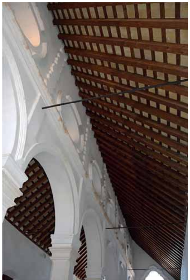
ARCADA CENTRAL DE LA NAVE DE JESÚS. (FOTOGRAFÍA DEL AUTOR)
