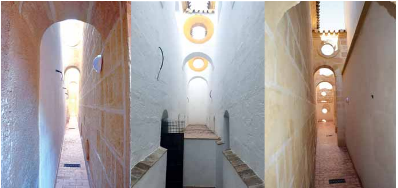
SISTEMA DE CONTRARRESTOS, PATIOS DE CONTRAFUERTES DE JESÚS, CENTRAL Y DE MARÍA DE LA CILLA DEL CABILDO DE OSUNA. (FOTOGRAFÍAS DEL AUTOR)
