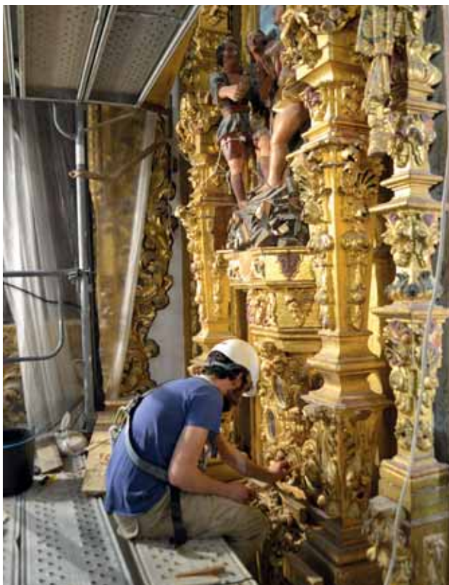
SELLADO DE GRIETAS.
