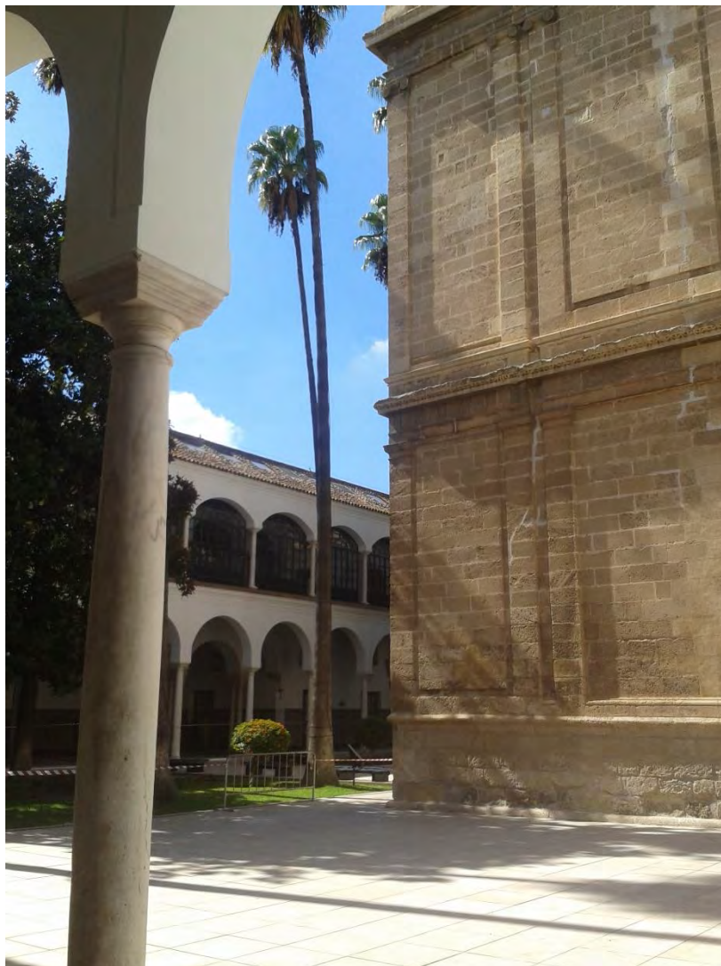
Detalles del edificio de la capilla del Hospital de las Cinco Llagas donde podemos comparar su altura y suntuosidad con la Parroquia de Santa Catalina.
