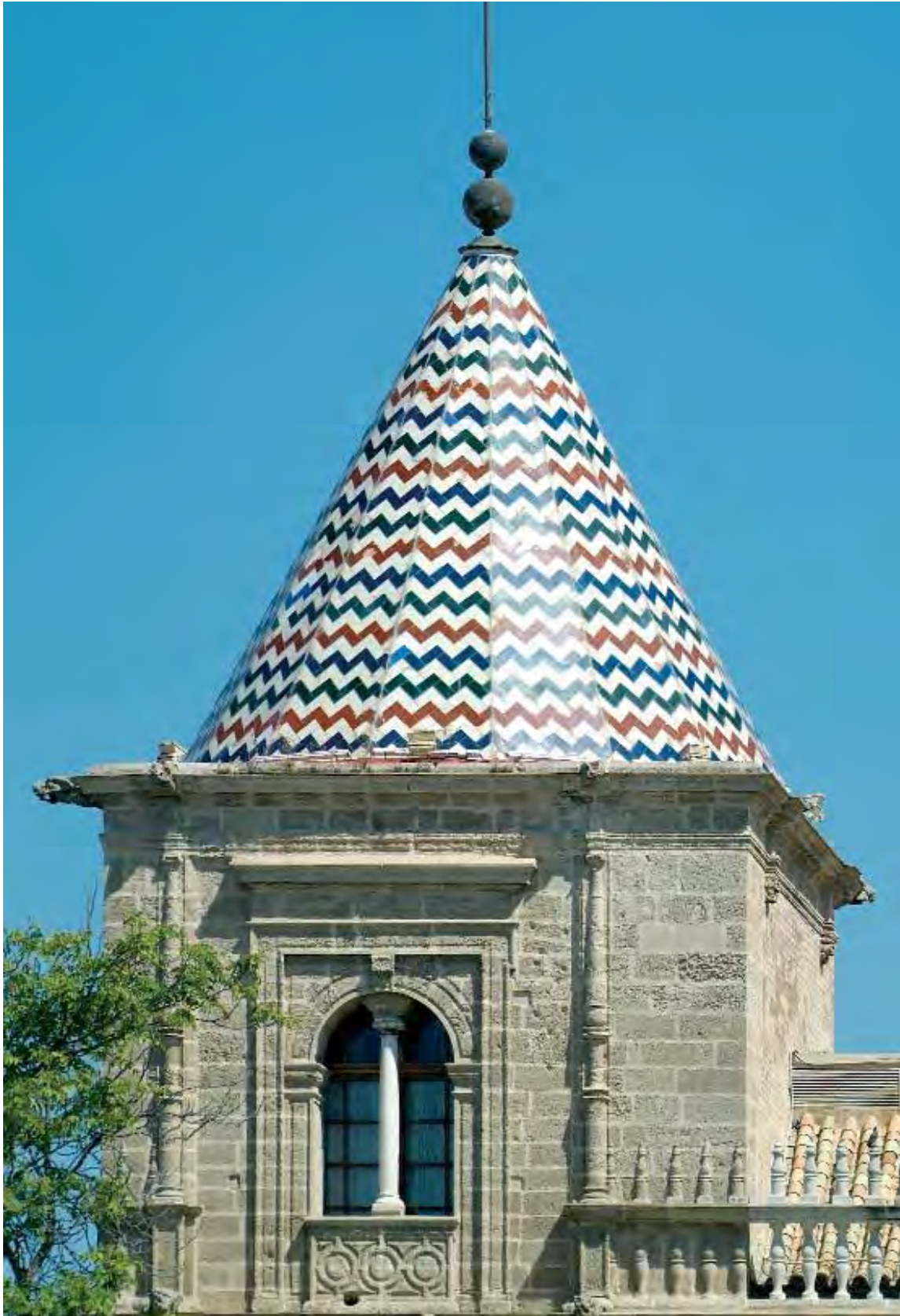
Torre oeste del Hospital tras la restauración del conjunto arquitectónico. Los azulejos blancos, verdes, amarillos y azules destinados a los chapiteles de las torres son del ceramista Roque Hernández
