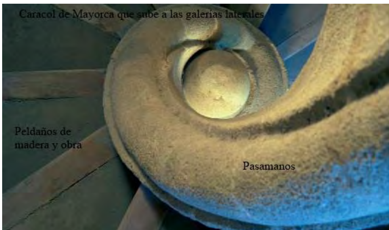
Escalera por la que se asciende a la sacristía, terraza, cubiertas y espadaña
