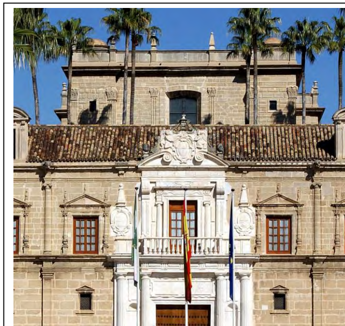
El alzado de la capilla del Hospital de las Cinco Llagas sobresale sobre el resto del complejo edilicio marcando claramente dos alturas, pero quedando disimulada a la vista desde el exterior.
