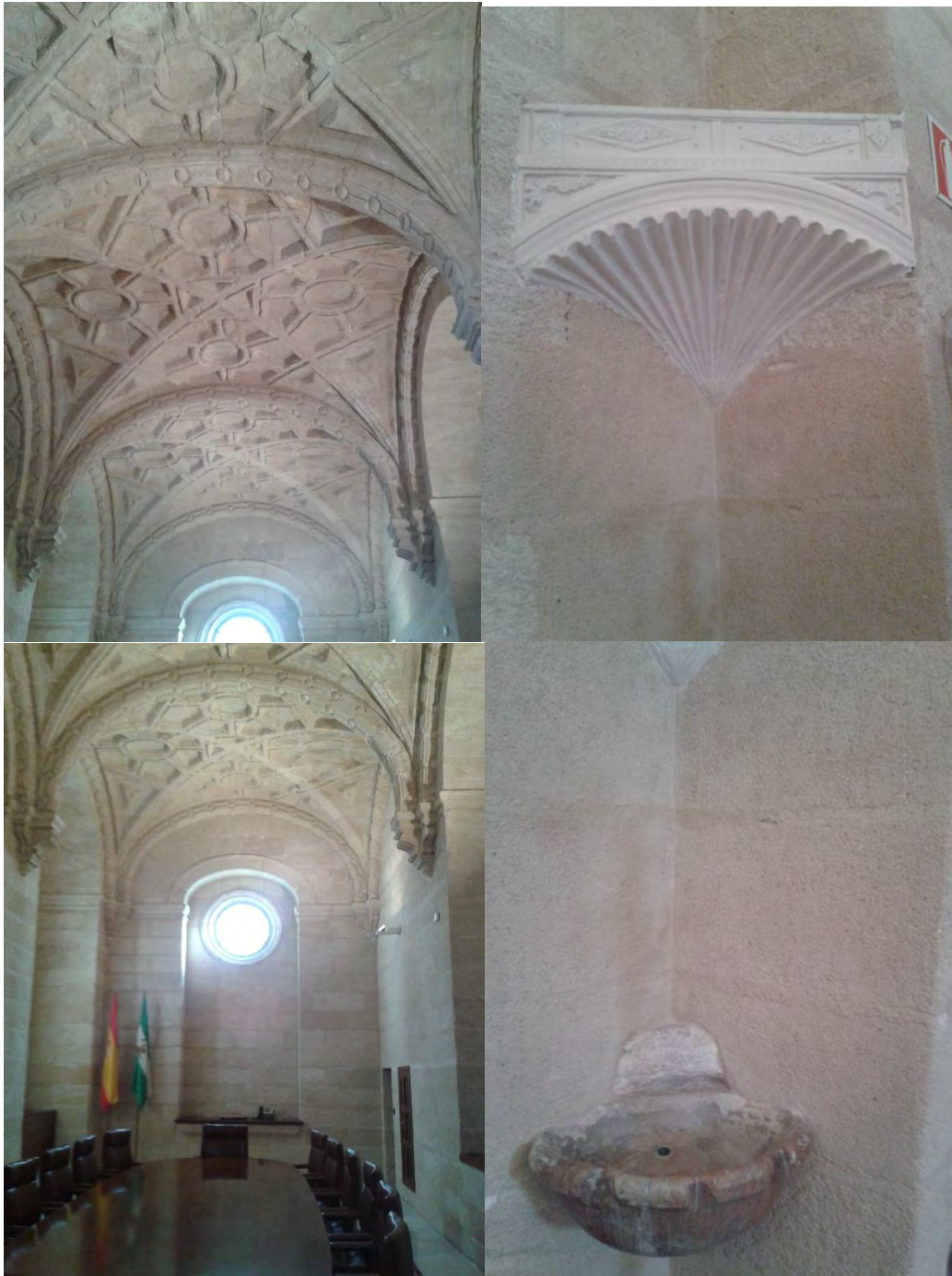
Detalles de la sacristía, hoy habilitada para usos parlamentarios.
