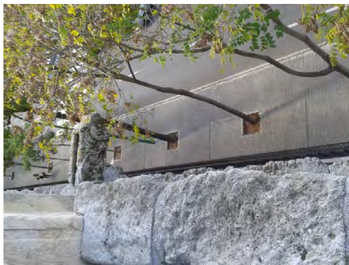
Detalle de la cornisa
