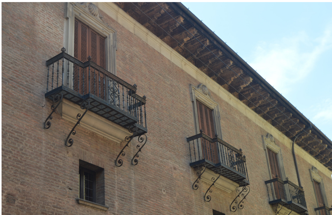
Fig.8. Julio Pascual. Reja de los balcones de Casa de Cervantes. 1930. Real Colegio de España. Bolonia. Italia. Fotografía: Autores.
