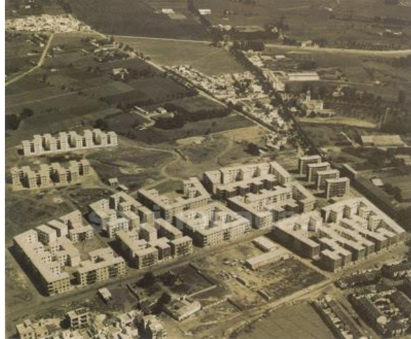
Perspectiva aérea de Pío XII en obras. Archivo de los arquitectos hermanos Barquín y Barón
