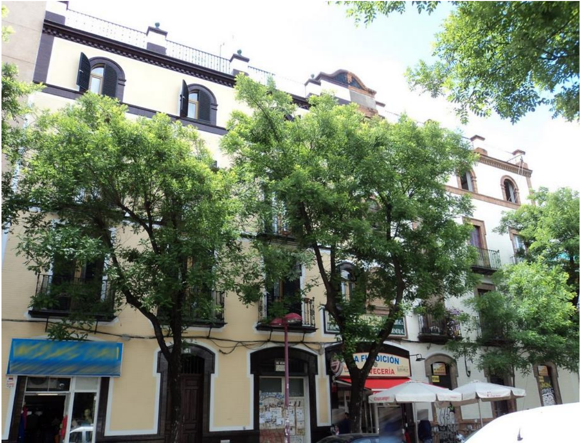
Viviendas en el edificio reutilizado de la Fundición de Bronce y Grifería Lucio Izquierdo. Alguna cartelería de establecimientos comerciales recuerda el origen del edificio.
