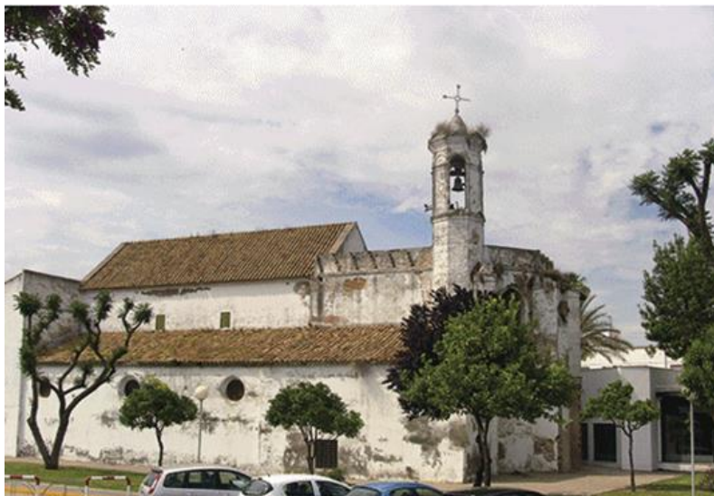
Actual estado del Hospital de San Lázaro, capilla y campanario.
