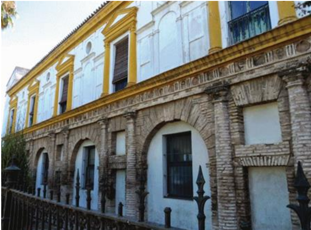
Detalles de la fachada
