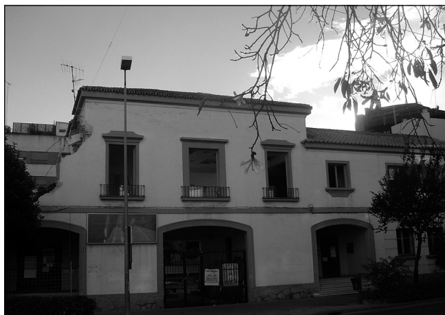
Demolición de la Casa Sindical, 2012. FUENTE: Archivo propio, 2012.
