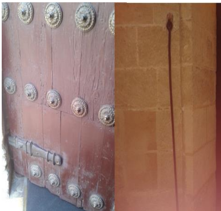
Detalle de la puerta Este de la capilla y de la tranca de hierro que sujeta la puerta
