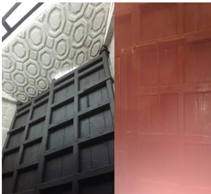
Puerta Este vista desde dentro y detalle del cerrojo
