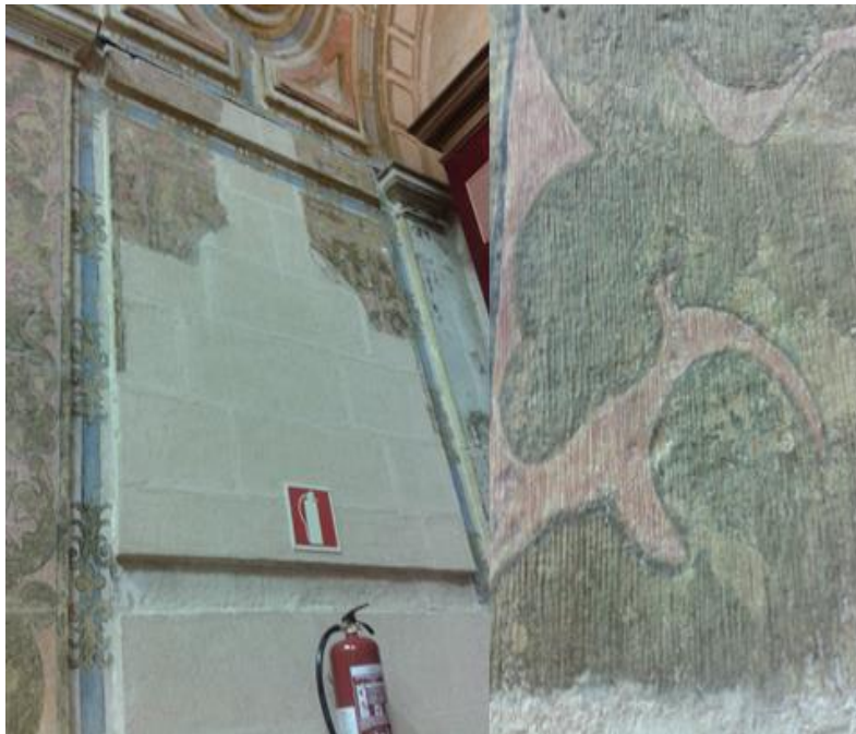
Lugar en el que se ubicaba uno de los altares de la capilla del Hospital de las Cinco Llagas y detalle de sus frescos, junto a la contemporánea prevención de riesgos
