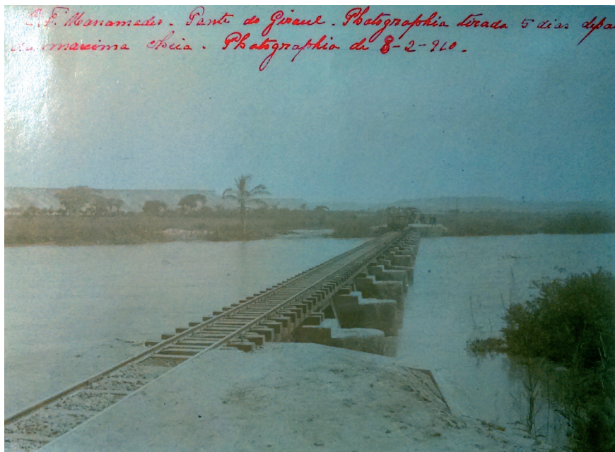
Fig. 6. Ponte sobre o Giraul (1910).
