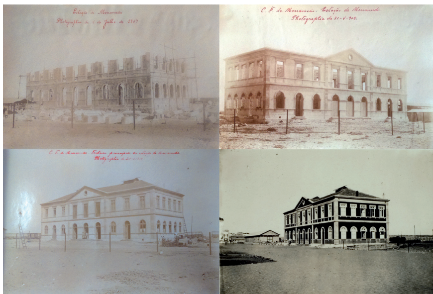
Fig. 3. Estação de Moçâmedes em diversas fases da sua construção (1907-1910).
