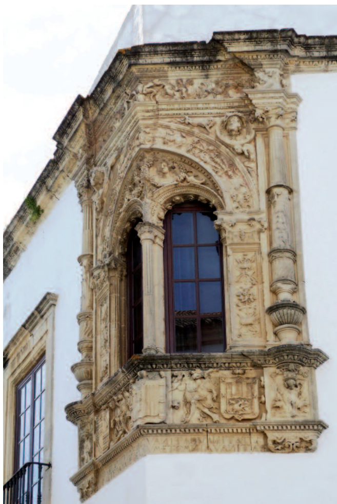
Fig. 12. Jerez de la Frontera. Palacio Ponce de León. Ventana en esquina.
