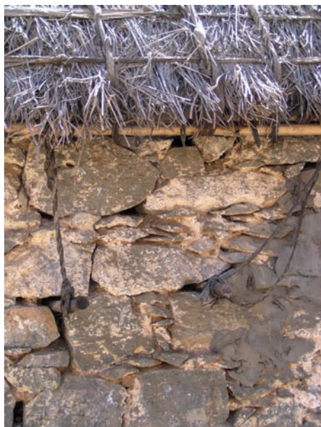
Fig. 15 Pormenor de um muro de cabana de planta ortogonal da ilha vizinha de Santo Antão, tal como a identificada no concheiro de Salamansa, de pedra seca, observando-se o processo de fixação da cobertura, através de espigões de ferro cravados no paramento externo (foto de B. Ferreira).
