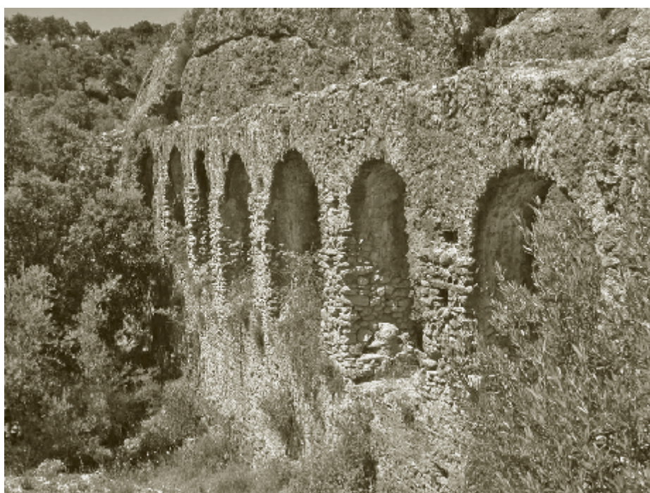
Figura 14. Acueducto de la Fuente de la Arena. Ronda
