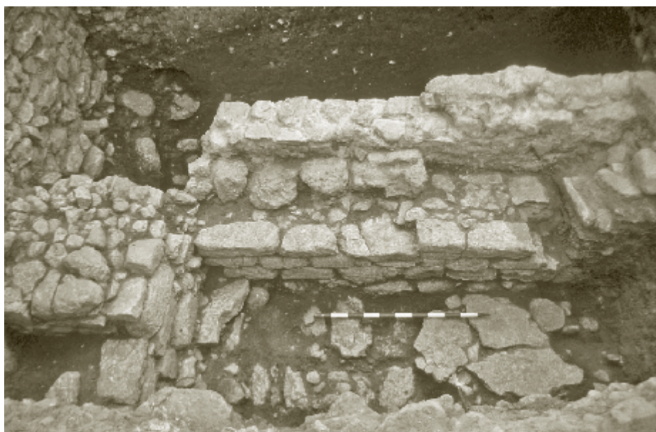
Figura 13. Muro de terraza romana junto a la iglesia de Santa María la Mayor de Ronda
