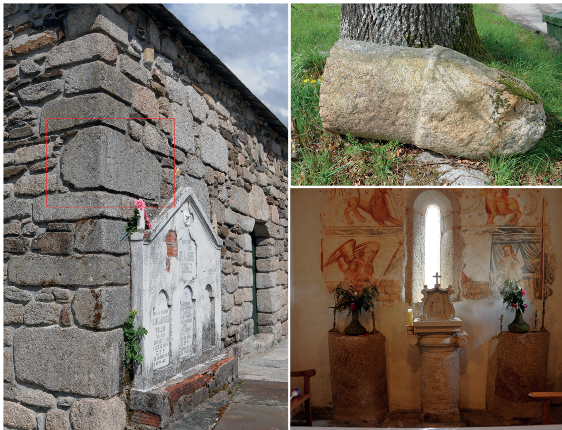
Figura 10. Fragmentos de antiguos miliarios romanos reutilizados en la iglesia de Tórdea y su entorno. A la izquierda (indicado por el rectángulo rojo), mitad de un miliario reaprovechado como sillar en el esquinual Suroeste de la iglesia. Arriba a la derecha, fragmento inferior de miliario en un campo a 80 metros al sur de la iglesia. Abajo a la izquierda, dos mitades longitudinales de miliario apoyadas contra el ábside en el interior de la iglesia. Fotografías de los autores.
