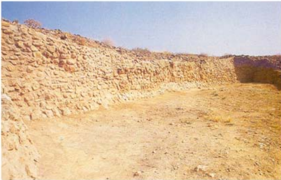
2. Vista general de la muralla.
