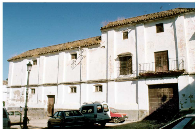
Lám. 22. Vista general de La Cilla. 15 de marzo de 2001. AMP.
