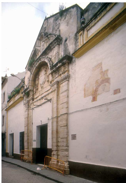
Lám. 29. Fachada de las Carnicerías reales. 27 de marzo de 2001. AMP.
