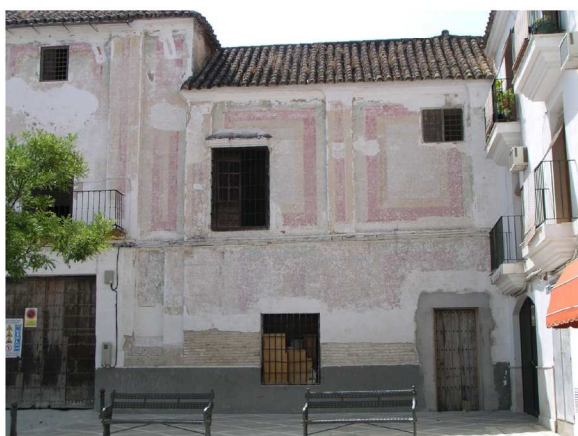
Lám. 23. Inicio del proceso de rehabilitación y restauración de La Cilla. 1 de enero de 2002. AMP.
