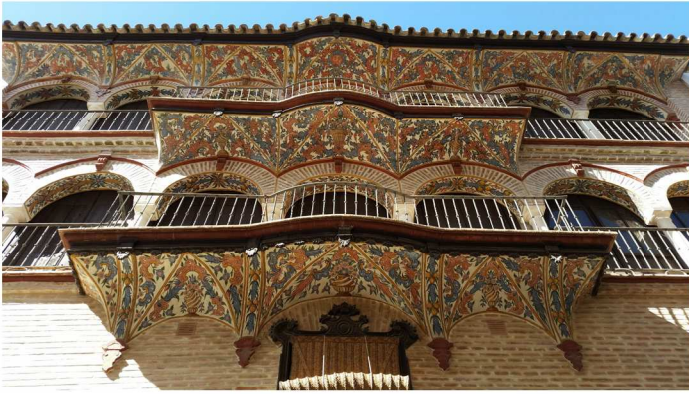
Lám. 43. Estado actual tras su restauración. ICG.
