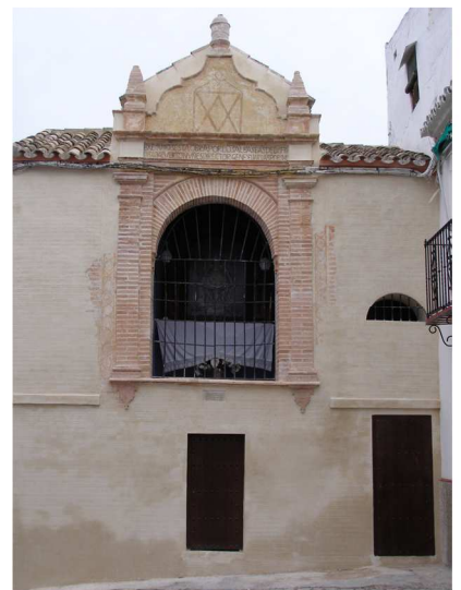
Lám. 55. Capilla de la Virgen del Valle en la calle de San Antonio tras su restauración. 17 de octubre de 2014. ICG.
