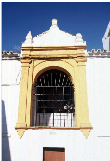
Lám. 54. Capilla de la Virgen del Valle en la calle de San Antonio. 14 de febrero de 2001. AMP.
