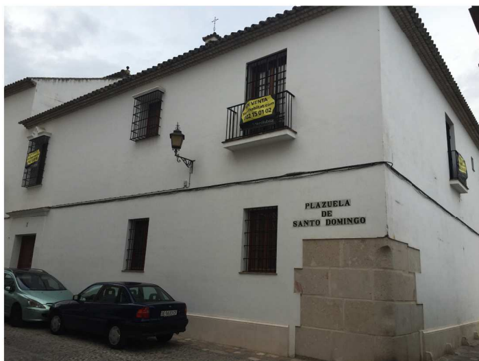
Lám. 1. Esquina de sillares de piedra de la Casa del Poeta Garcí Sánchez de Badajoz. Fotografía: Inmaculada Carrasco Gómez (ICG).
