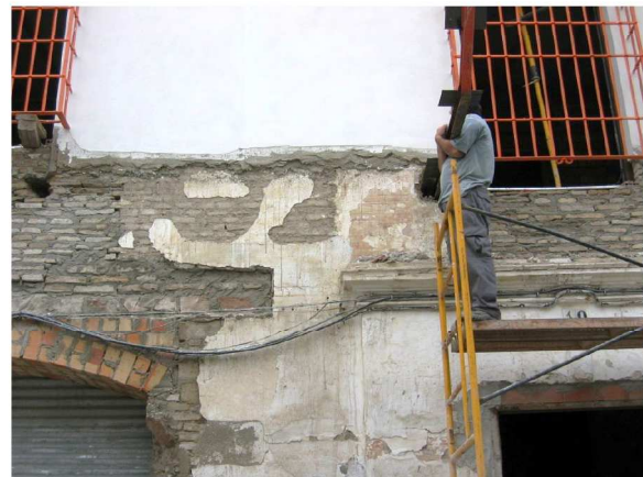
Lám. 10. Imitación de ladrillos en calle de La Marquesa nº 10. Fotografía: Gerardo García León.
