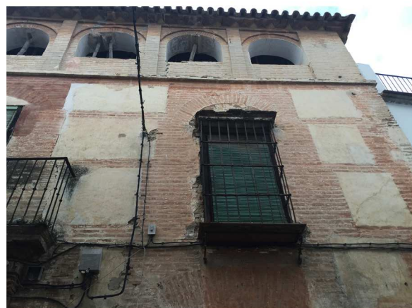
Lám. 12. Imitación de tapial y ladrillo en casa nº 13 de la calle José Canalejas. AMP.
