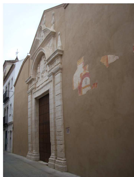
Lám. 30. Fachada de las Carnicerías reales tras su restauración. 7 de noviembre de 2010. ICG.
