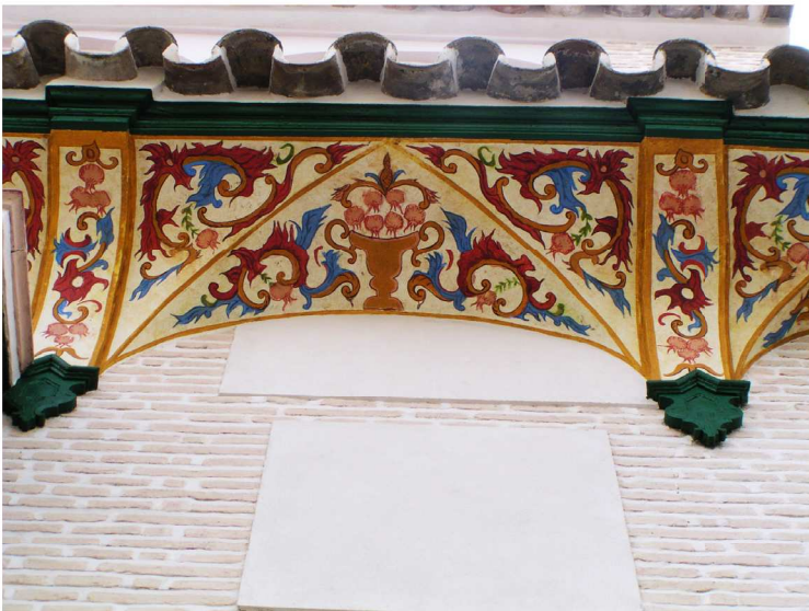
Lám. 47. Detalle del guardapolvo del balcón, tras su intervención. No tiene nada que ver con lo que había. ICG.
