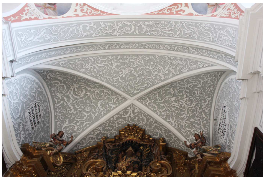
Lám. 24. Bóveda del presbiterio de la iglesia parroquial de San Gil Abad. (RSGA).
