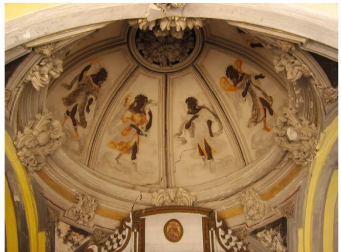
Lám. 30. Cúpula de la Capilla de Nuestro Divino Salvador. Compás de la Iglesia del Convento de San Antonio de Padua vulgo de San Francisco. (AMP).
