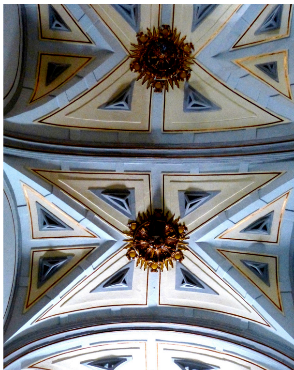
Foto 6.- Bóvedas de la iglesia del santuario de la Virgen de Cortes (Alcaraz). Fot. J. S. Ferrer.
