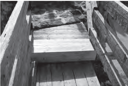
Castillo. Trabajos de mantenimiento en la tablazón del recorrido turístico.
