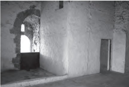
Castillo. Acceso medieval (izquierda) con parapeto de protección anticaídas.
