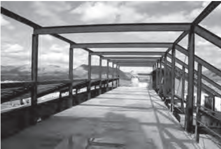
Nueva sede del Museo en obras. Planta superior.
