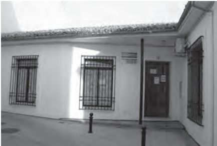
Escuela deshabilitada de c/ Santa Teresa. Fachada.
