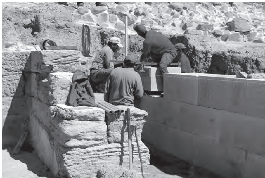
Reposición de sillares en la curia
