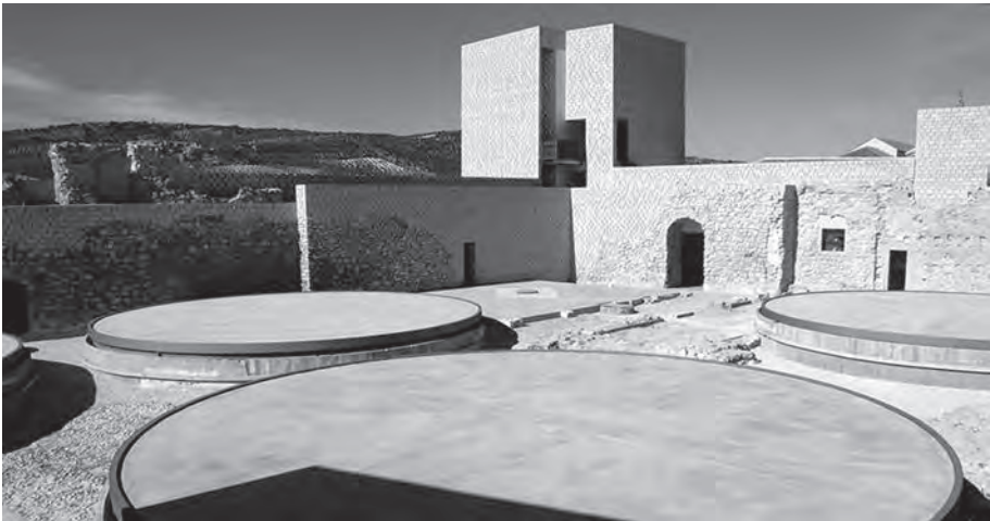
Panorámica del interior del castillo
