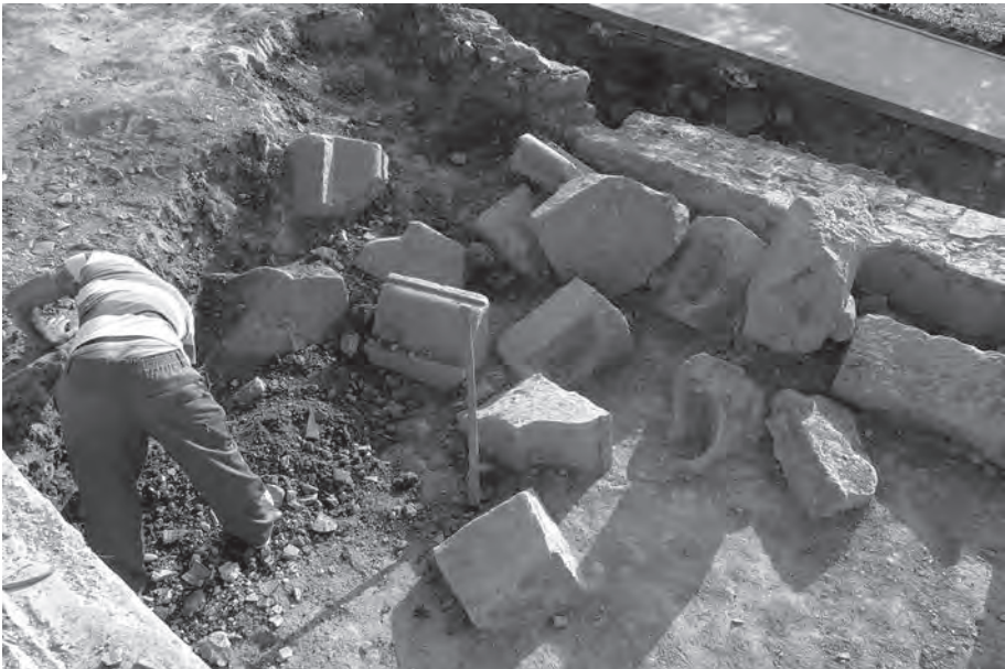
Derrumbe de elementos arquitectónicos caídos en una de las salas
