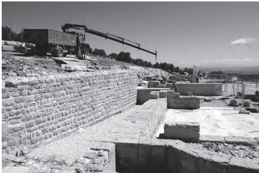
Aspecto del pasillo de la curia con el muro norte restaurado
