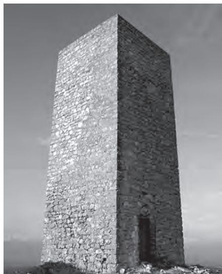
La Torre del Montecillo recién restaurada
