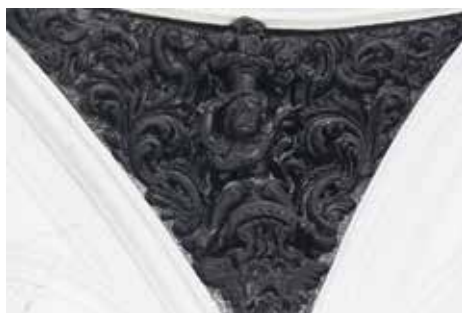
Ilustración 21. Relieve de la escalera. Hospital de Mujeres. Cádiz (Fotografía A. Aguayo)
