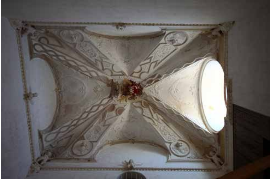
Ilustración 3. Bóveda de la escalera (Fotografía A. Aguayo)
