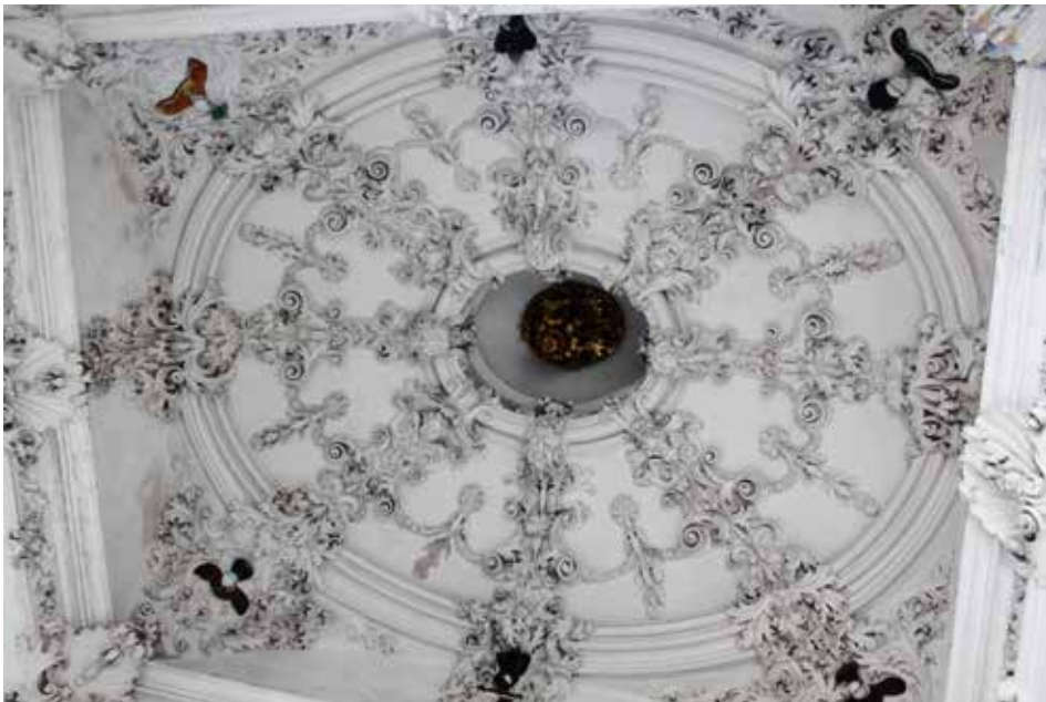
Ilustración 18. Bóveda de la escalera del Hospital de San Juan de Dios (Fotografía A. Aguayo)
