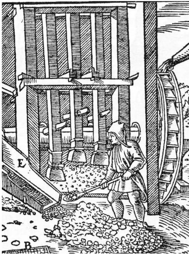
Figura 7. Molienda con martillos pisones movidos por árbol de levas, accionado por rueda hidráulica (Agrícola, *De Re Metallica*, Libro VII, 1556).
