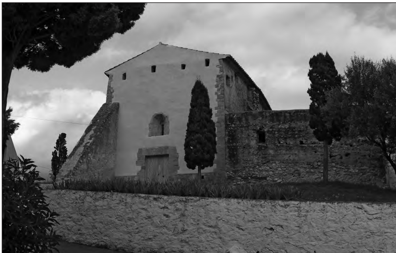
Figura 56. Torre Blanca. Restos de la muralla del husun lindante con la ermita de S. Francisco.
