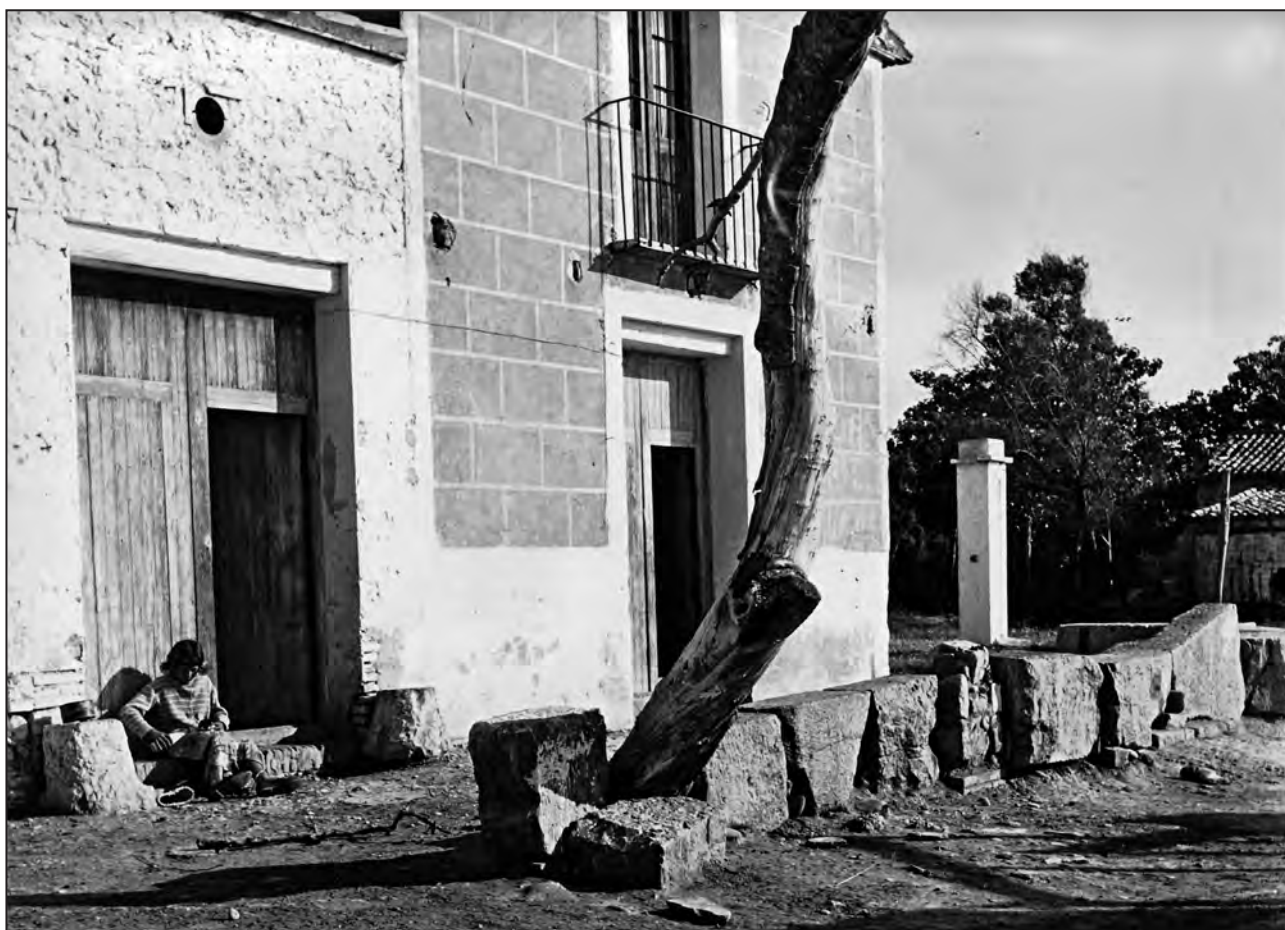
Figura 27. Burriana. La alquería de Cano protegida del mar con sillares romanos. (Safont, 1966).
