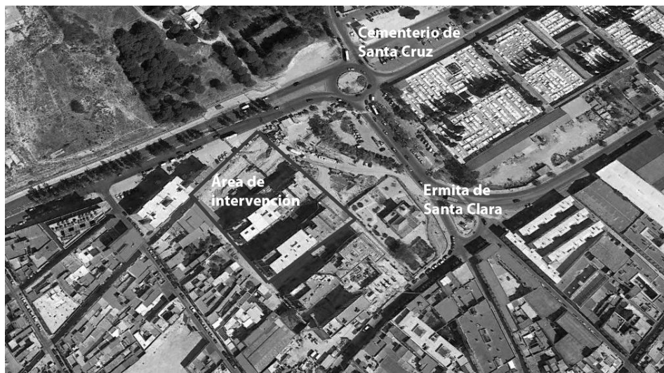
Figura 1. Vista aérea del Entorno de la Ermita de Santa Clara. Fotografía de Google Earth
