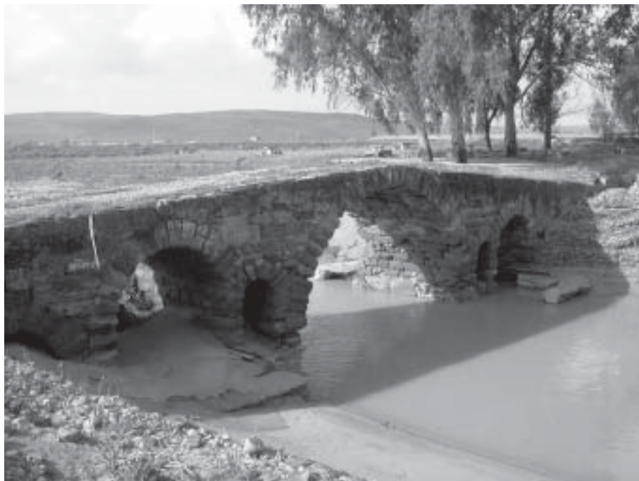
Foto vista del puente romano, S.O.S.
