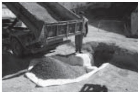
Unidad de Ejecución 28 (Prolongación c/ Zurbarán). Cubrición de estructuras arqueológicas con geotextil y grava.
