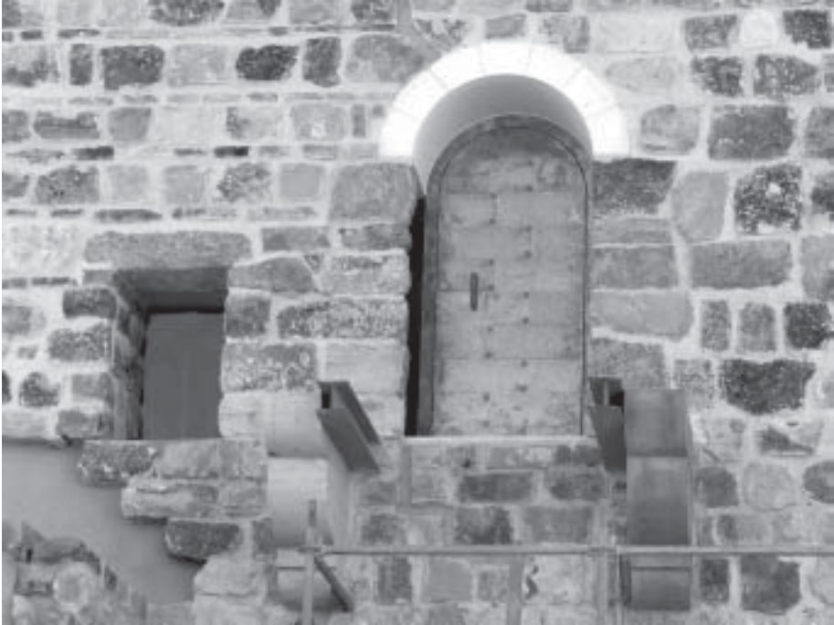
Detalle del acceso a la torre con la nueva puerta de cobre
