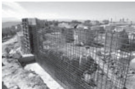
Construcción del muro de hormigón en el lado este del edificio
