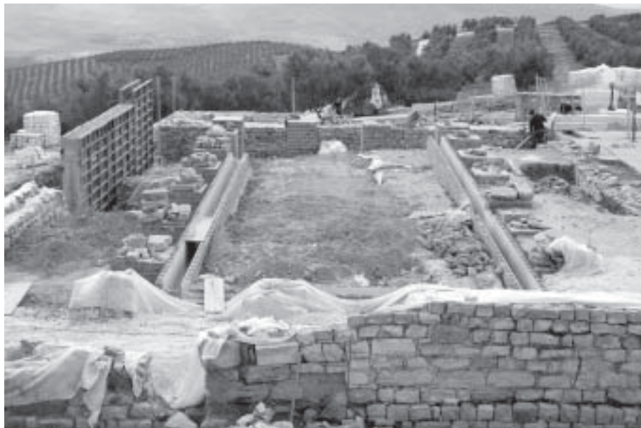
Un momento de los trabajos de restauración
