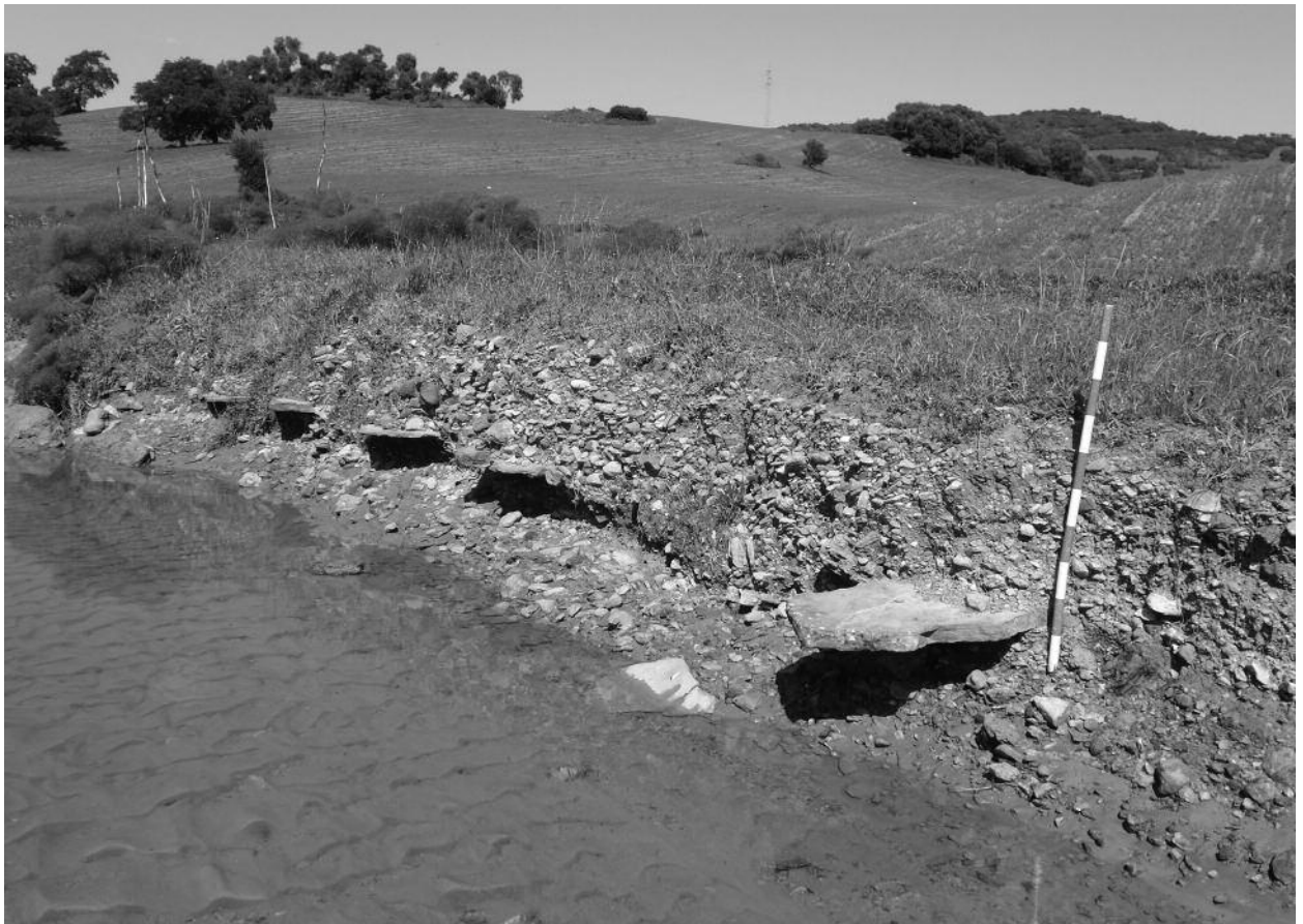
Figura 4. Perfil estratigráfico formado por el arroyo Hondo y detalle de las lajas de piedra arenisca que constituyeron las balsas salineras.
