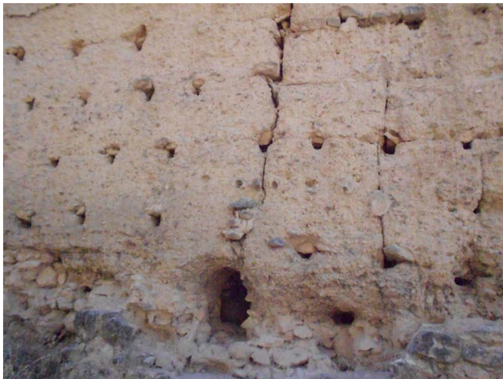
Muralla norte de Jaén. Huellas de los mechinales en el tapial almohade que reviste la muralla para reforzarla. Parte interna de la muralla, intramuros de la ciudad. Fotografía: Francisco Vidal Castro
