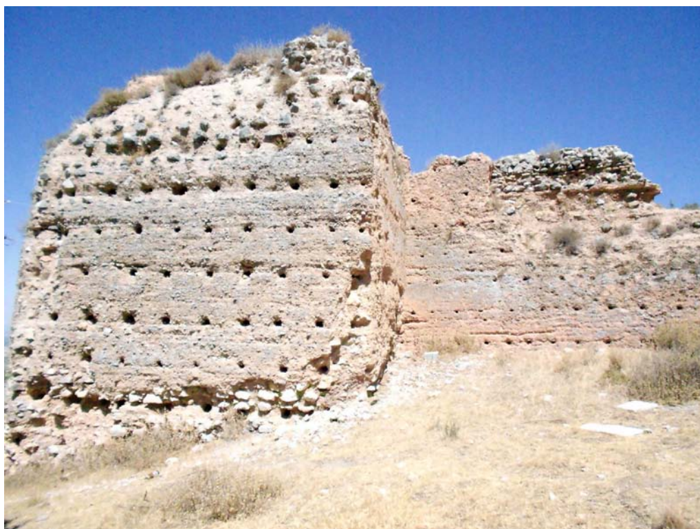
Muralla norte de Jaén. Torre junto al desaparecido Postigo de La Llana. Parte externa de la muralla, extramuros de la ciudad. Fotografía: Francisco Vidal Castro
