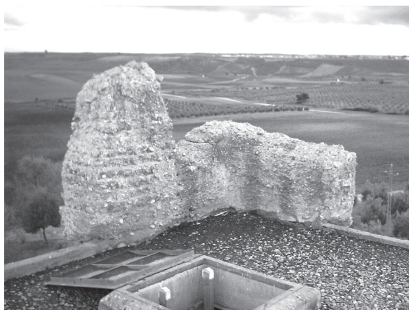
Lám. 11: Restos de crestería fotografiados antes de la restauración de la torre.
