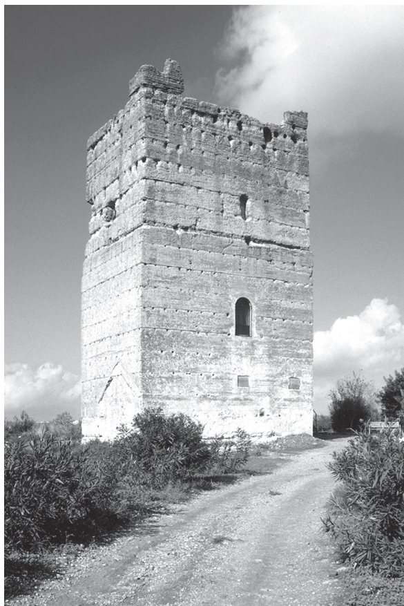
Lám. 5: Antigua foto con la torre vista desde el sur, en la que se aprecia bien la técnica del tapial.
