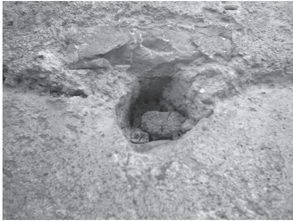
Lám. 7: Marca de aguja de caja de encofrado y restos de madera en su interior, visible antiguamente en la cara oeste.
