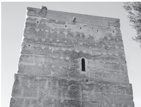
Lám. 8: Hilada de ladrillos en la parte superior de la fortificación.
