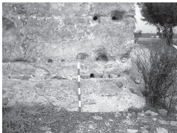
Lám. 10: Detalle de la cimentación o basamento de la torre en el ángulo suroeste (foto antigua).
