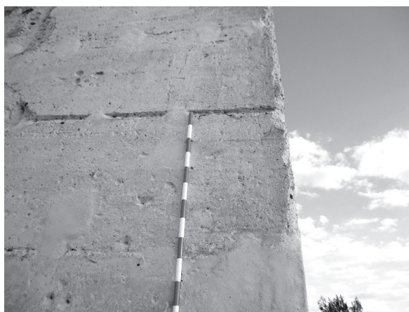
Lám. 29: Detalle de las tapialadas de la torre, de unos 85-90 cm de altura.
