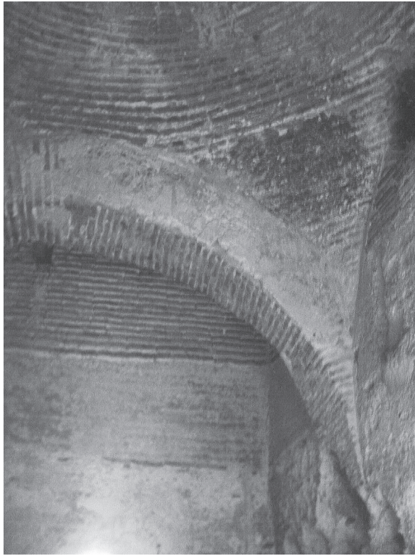
Lám. 20: Detalle del arranque de la bóveda superior.
