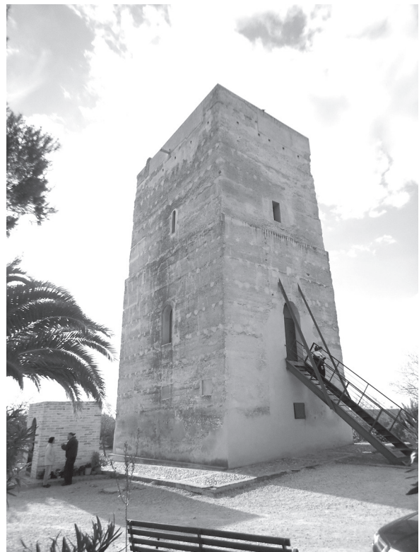
Lám. 4: La Torre de Don Lucas y su nuevo aspecto tras ser restaurada.
