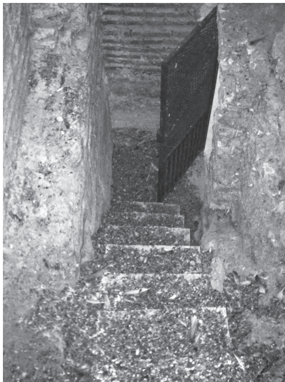
Lám. 19: Escalera entre la planta central y la superior.
