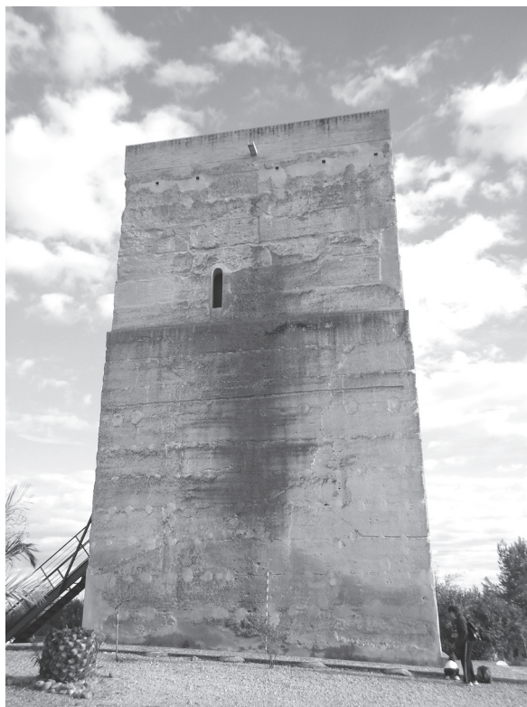
Lám. 6: La torre vista desde el oeste, desde donde puede distinguirse bien el estrechamiento de la planta superior.
