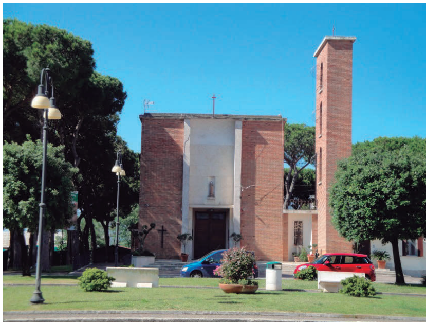
Fig. 5. Iglesia de Borgo Montenero (Agro Pontino). (Fotografía de los autores).
